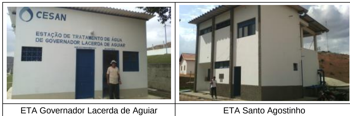
Figura 24 - Registro das instalações de tratamento de água
