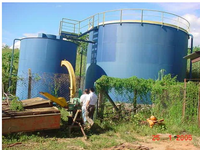
**Figura 19-** Reator UASB existente.
