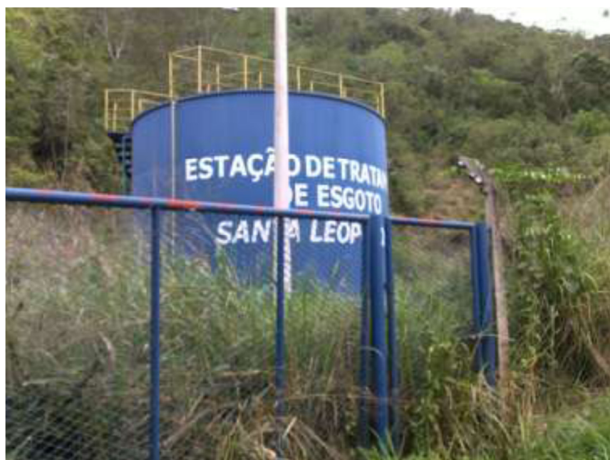
Figura 29: Estação de Tratamento de Esgoto do Distrito Sede de Santa Leopoldina.
