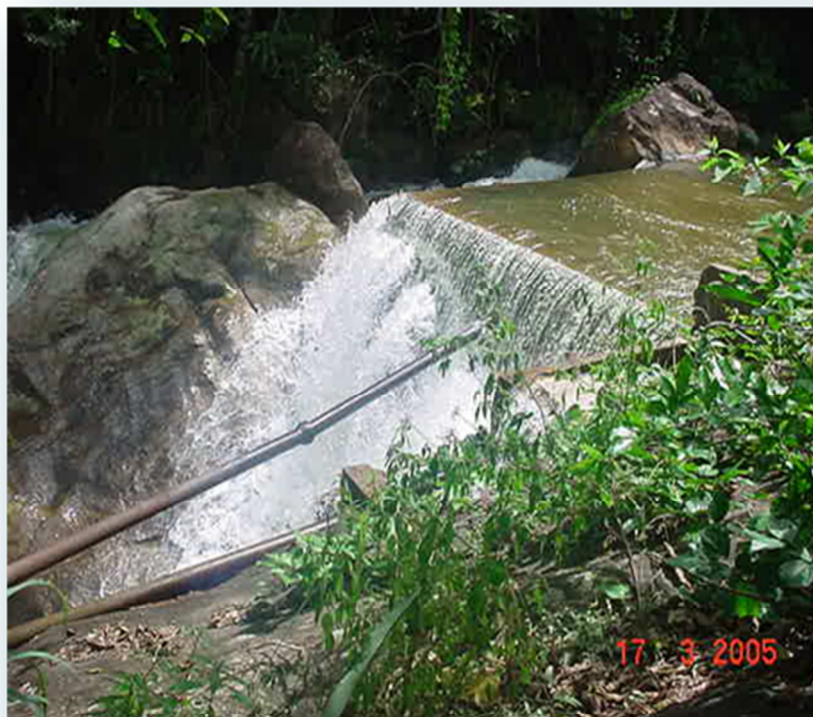
Figura 20: Barragem do Rio da Prata.
