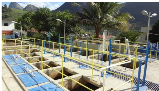
Figura 3-18 - Estação de Tratamento de Água.
