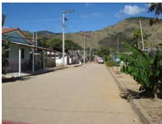
Figura 3-3: Edificações Residenciais, bairro Ipiranga
