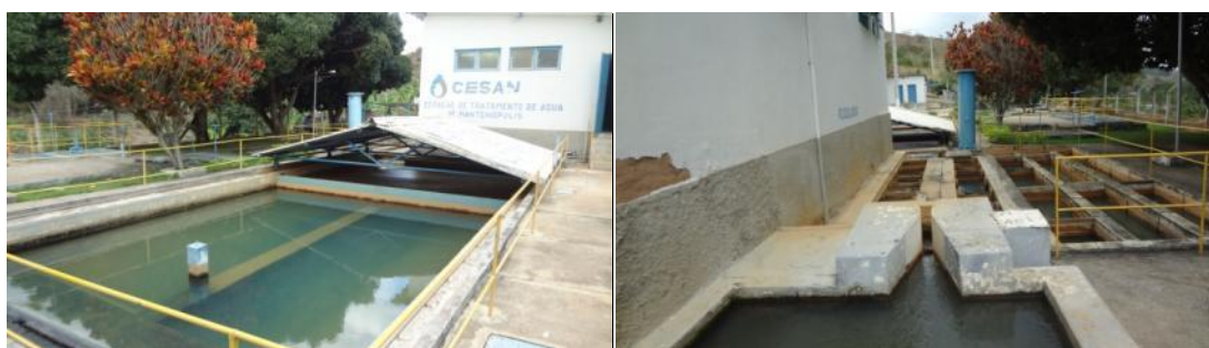
Figura 3-18 - Estação de Tratamento de Água - Sede.
