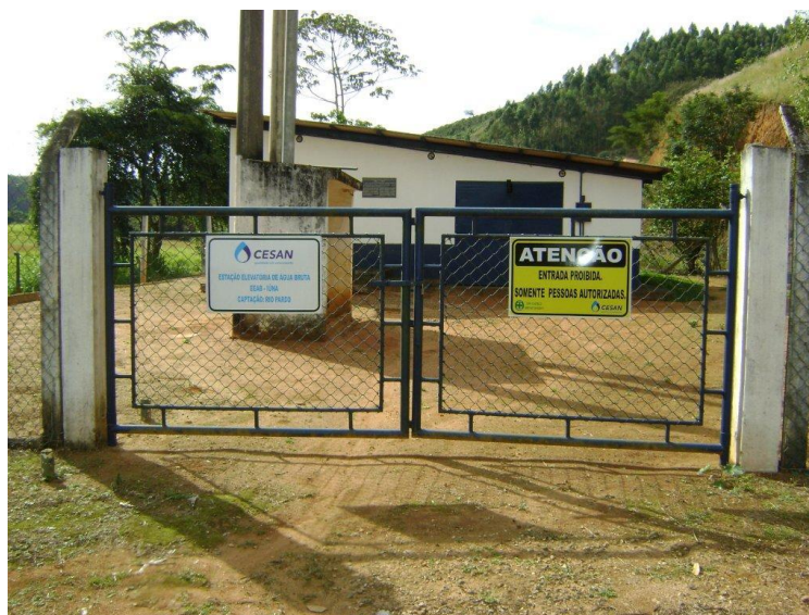
Figura 14: Estação Elevatória de Água Bruta.
