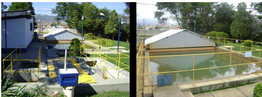
Figura 15: Filtros e Decantador que compõem a ETA
