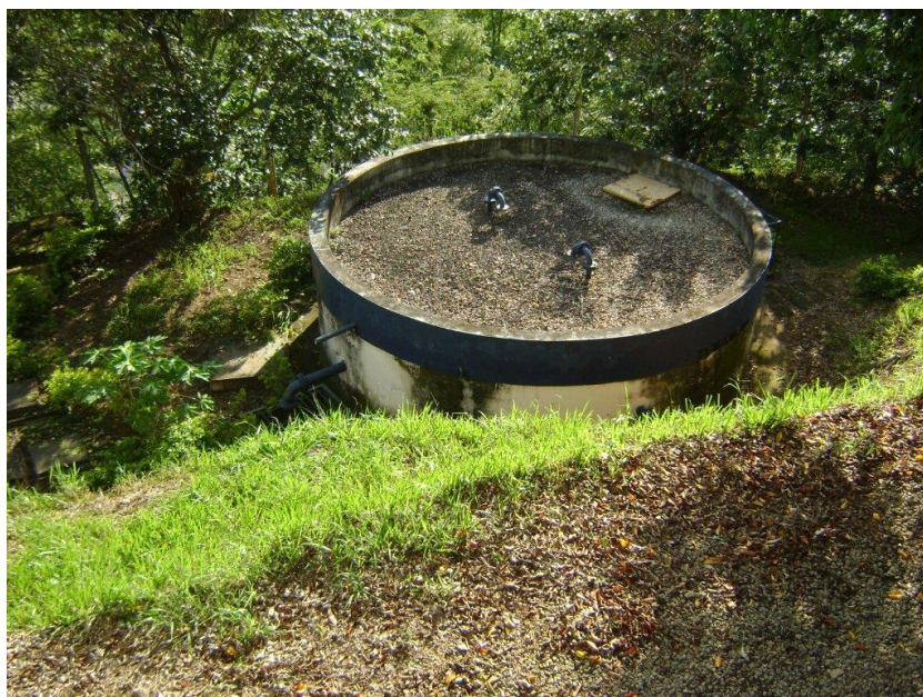
Figura 26: Reservatório semi-enterrado com capacidade de 50 m 3 .
