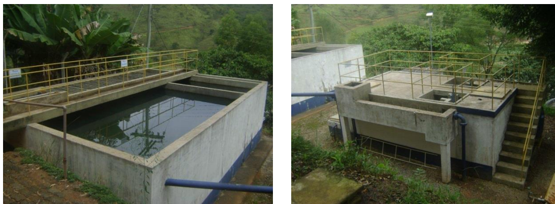
Figura 24: Floculador e Filtros da ETA
