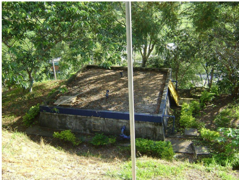
Figura 25: Reservatório semi-enterrado com capacidade de 40 m 3 .
