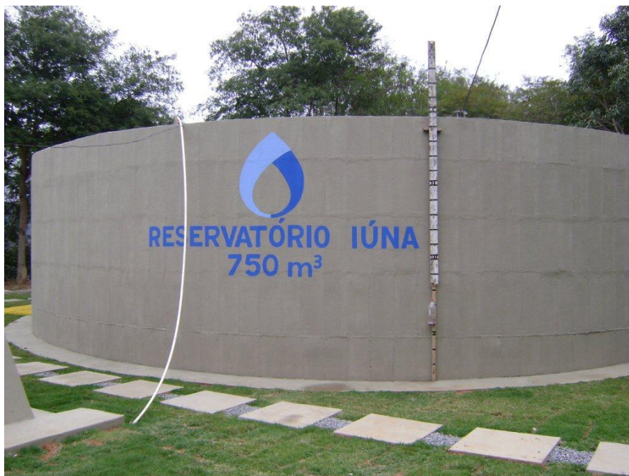
Figura 20: Reservatório semi-enterrado com capacidade de 750 m 3 .
