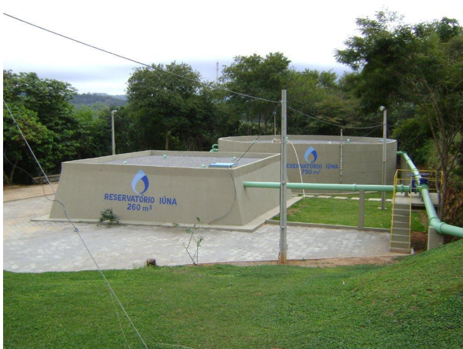
Figura 19: Reservatório semi-enterrado com capacidade de 260 m 3 .
