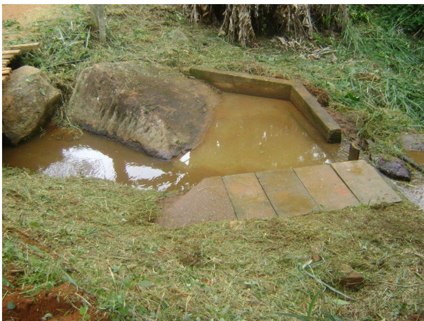
Figura 21: Captação Córrego Antonio Pedro
