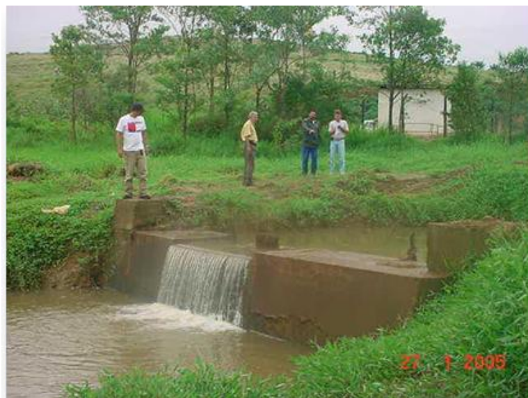
Figura 11: Captação Rio Pardinho
