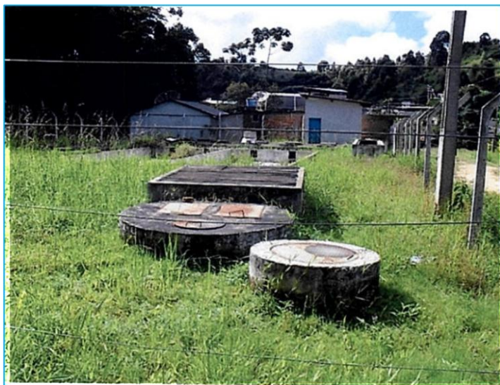
Figura 17: Vista da ETE no bairro Carolino Barbosa.
