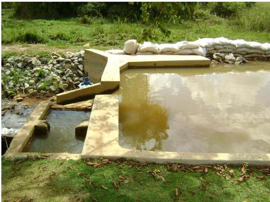
*Figura 11: Unidades de captação do Sistema de Água da Sede de Ibatiba*
