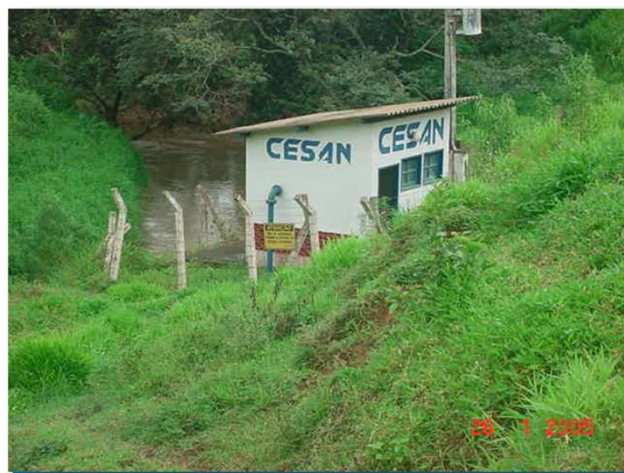
Figura 16: Captação Rio Preto
