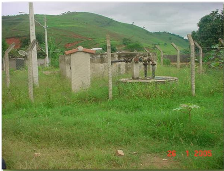
Figura 22: Vista da fossa filtro.
