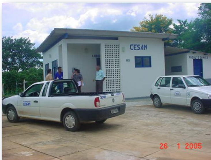
Figura 17: Estação de tratamento de água.
