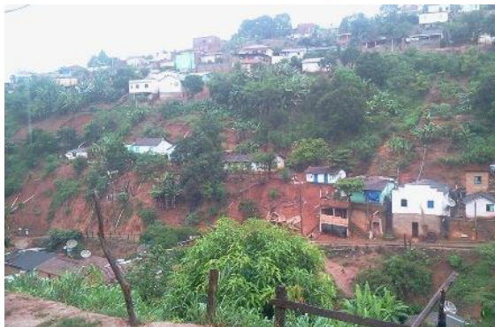
Figura 3-14 - Deslizamento no Bairro São Vicente.
