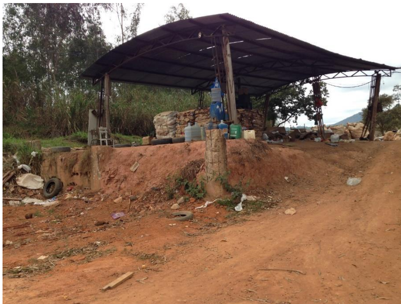
Figura 3-45 - Galpão de triagem.
