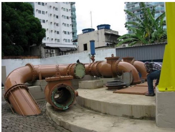
Figura 64 - EEEB EEVT 05 (Centro de Convenções).
