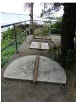
Figura 36 - Facilidade de acesso à EEEB Ilha do Frade 03.
