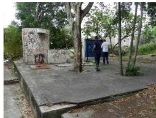
Figura 4 - EEEB Ilha do Frade 04 sem identificação.
