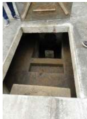
Figura 122 - Ausência de gradeamento na EEEB Santa Marta - Mangue Seco (PMV).
