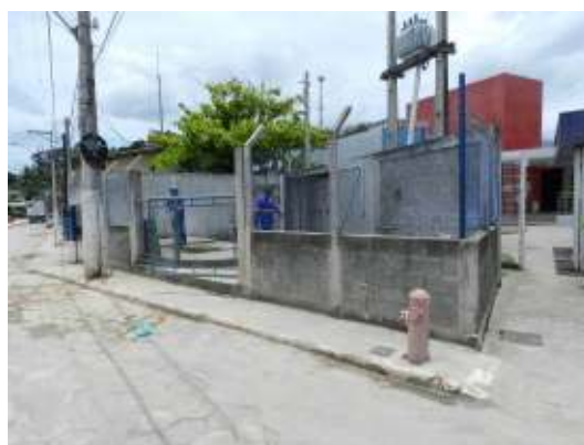
Figura 24 - EEEB 7.3 sem identificação.
