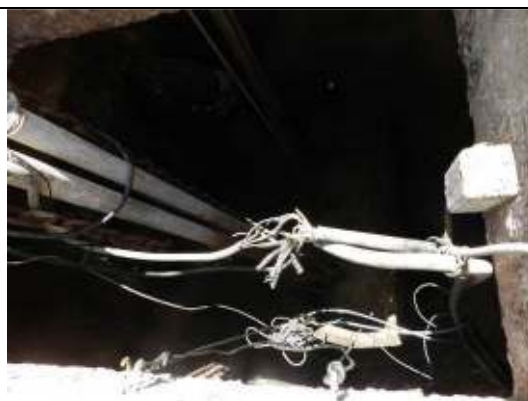
Figura 83 - Fiação exposta no poço de sucção da EEEB 1B (Dom Bosco).
