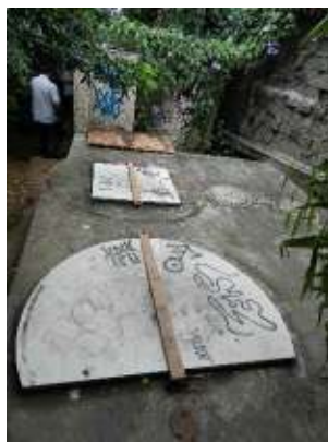
Figura 32 - Facilidade de acesso à EEEB Ilha do Frade 01.
