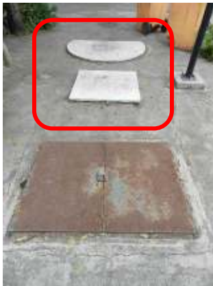
Figura 26 – Facilitade de acesso à EEEB Ilha do Boi 01.
