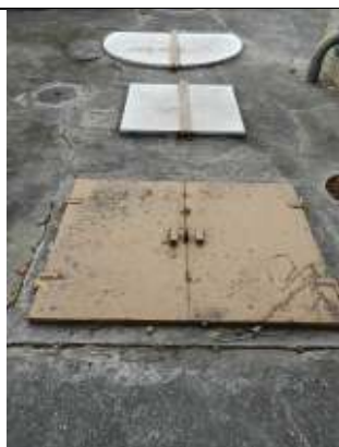
Figura 38 - Facilidade de acesso à EEEB Ilha do Frade 05.
