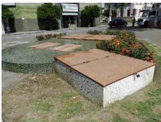
Figura 42 - Facilidade de acesso à EEEB C (Parque Moscoso).
