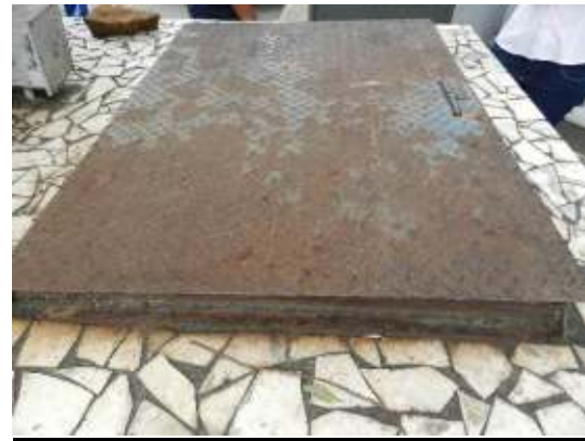
Figura 27 - Facilitade de acesso ao motor do biofiltro da EEEB Ilha do Boi 01.
