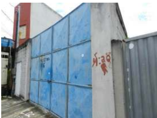
Figura 17 - EEEB 7.6 sem identificação.
