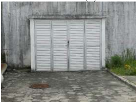
Figura 100 - Ausência de sinalização de risco na EEEB 4B.
