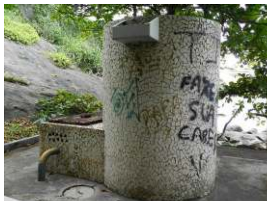
Figura 3 - EEEB Ilha do Frade 02 sem identificação.
