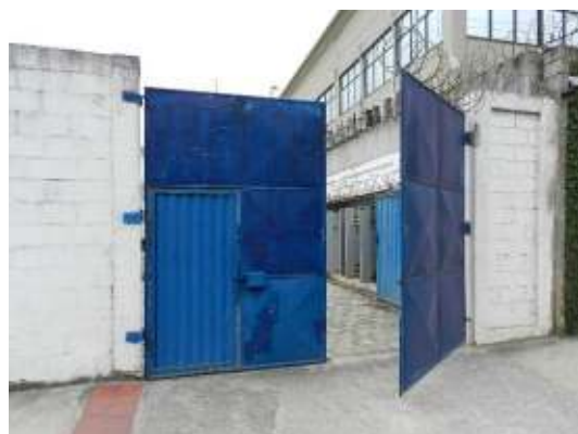
Figura 5 - EEEB 4A sem identificação.
