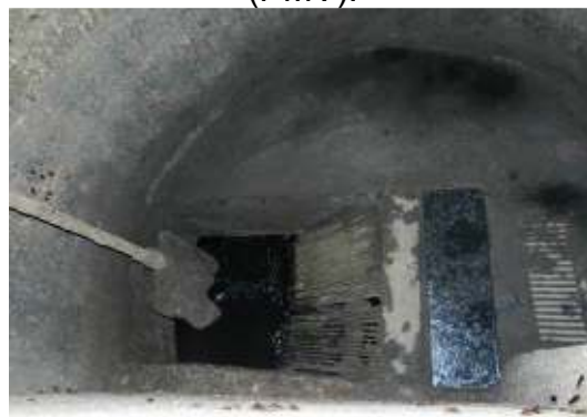
Figura 122 - Ausência de gradeamento na EEEB Santa Marta - Mangue Seco (PMV).
