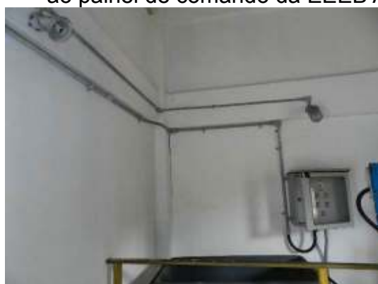
Figura 129 - Ausência de iluminação adequada na EEEB 3 (Bonfim) (a única lâmpada presente estava queimada).
