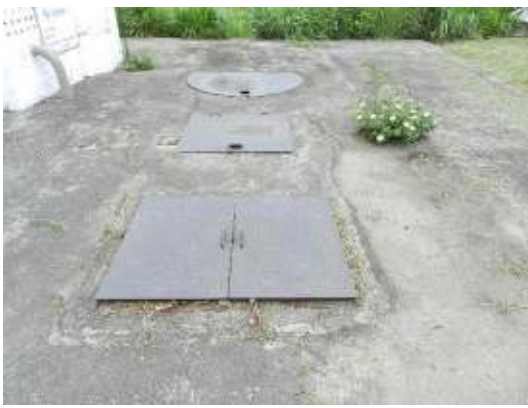
Figura 30 - Facilitade de acesso à EEEB Ilha do Boi 03.
