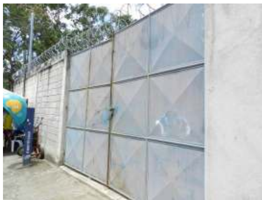
Figura 25 - EEEB 7.8 sem identificação.
