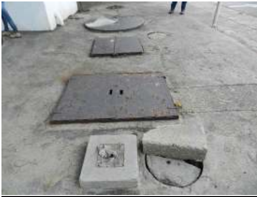
Figura 28 - Facilitade de acesso à EEEB Ilha do Boi 02.
