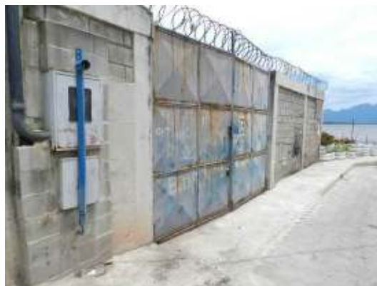
Figura 20 - EEEB 7.4 sem identificação.
