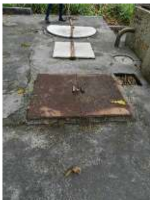
Figura 34 - Facilidade de acesso à EEEB Ilha do Frade 02.
