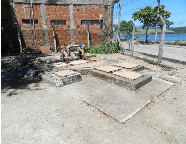
Figura 1 – Tampas do poço de sucção da EEB Prainha.
