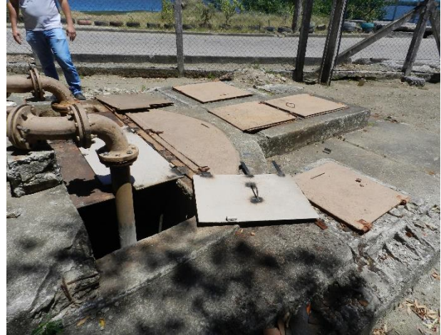
Figura 2 – Tampas do poço de sucção da EEB Prainha.
