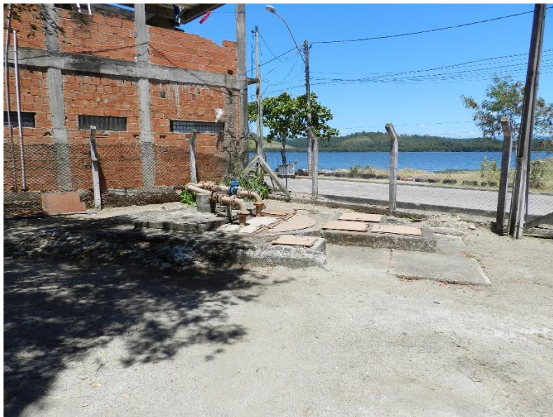
Figura 3 – Inexistência da parede apresentada no RF/DS/GSB/004/2017.
