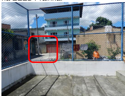
Figura 12 - Isolamento comprometido na EEEB 6.3 (Gde Vitória).
