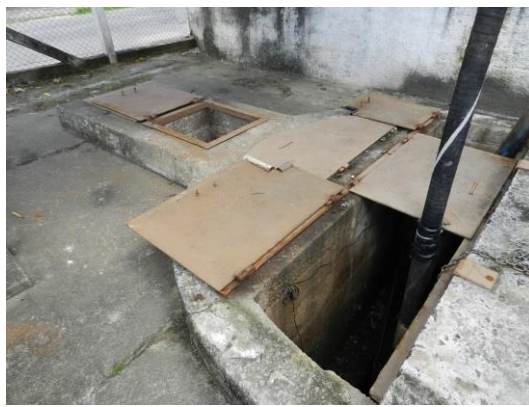
Figura 15 - Tampas do poço de sucção da ETEB Itabira necessitando de manutenção.
