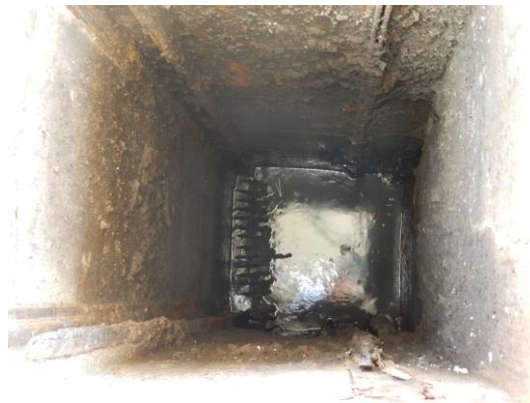
Figura 41 - Gradeamento da EEEB Prainha necessitando de substituição.
