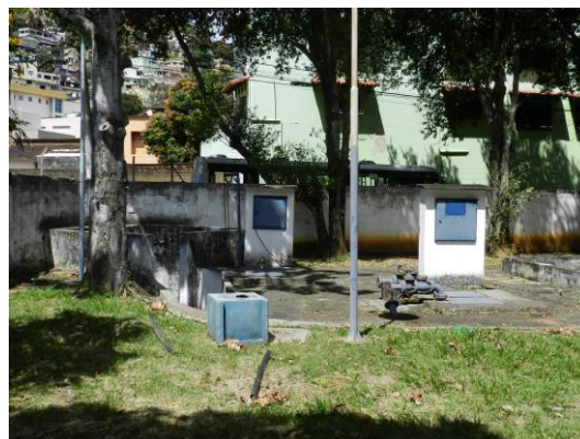
Figura 8 - EEEB Santa Teresa (ETE Desativada) sem identificação.
