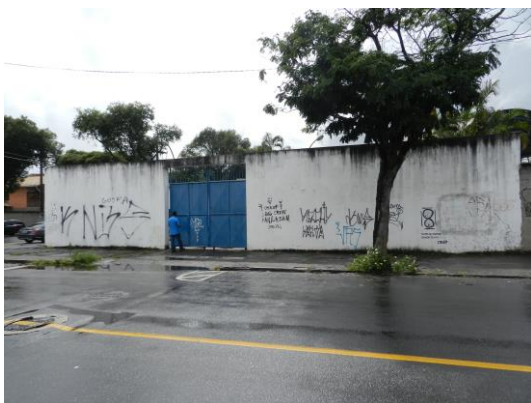
Figura 3 - EEEB Goiabeiras sem identificação.
