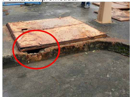
Figura 11 - Reboco deteriorado e presença de armadura exposta na EEEB Goiabeiras.
