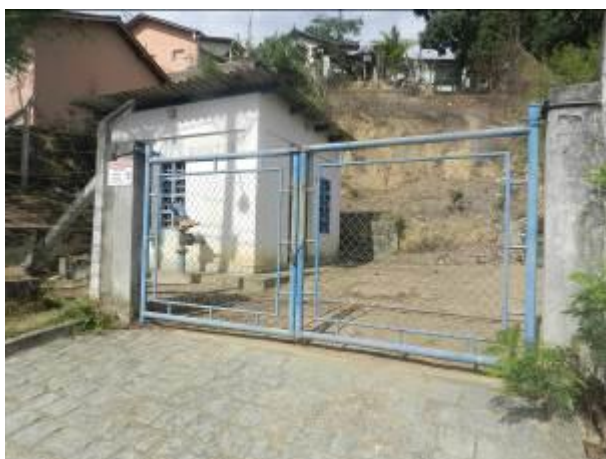
Figura 3 - Booster Vila Pavão.
