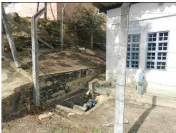
Figura 16 - Booster Vila Pavão.
