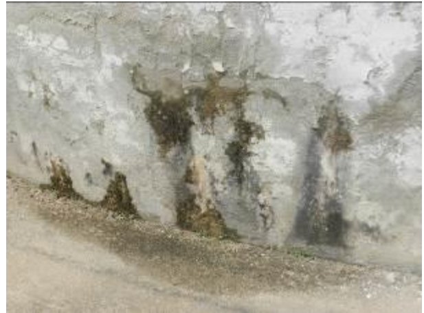
Figura 10 - Reservatório da ETA Vila Pavão.
