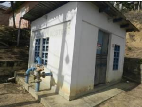
Figura 1 - Booster Vila Pavão.
