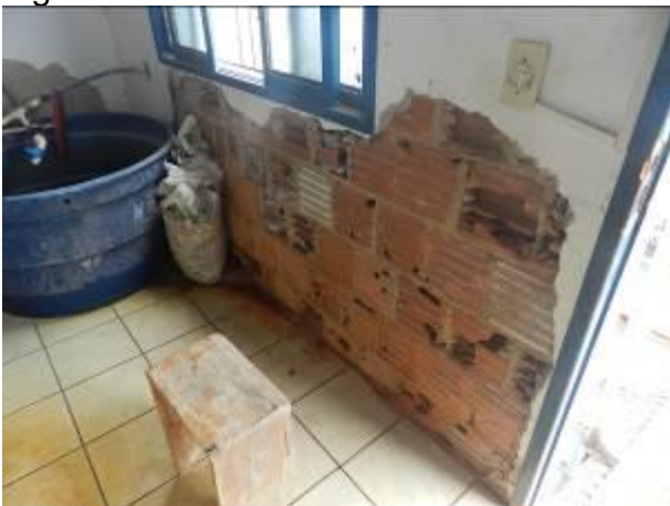
Figura 7 - ETA Vila Pavão.
