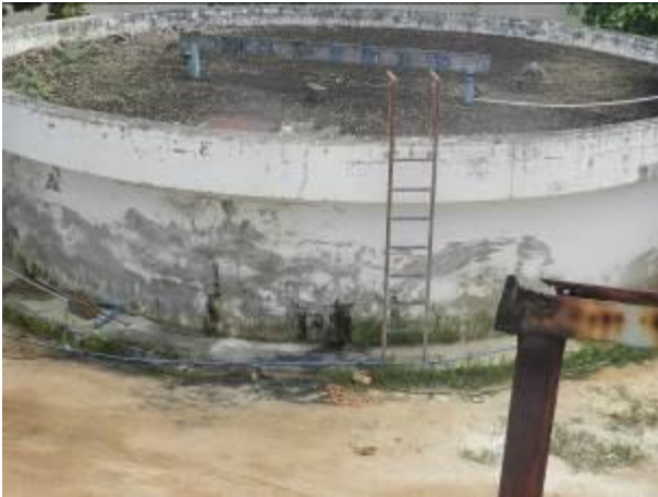
Figura 9 - Reservatório da ETA Vila Pavão.
