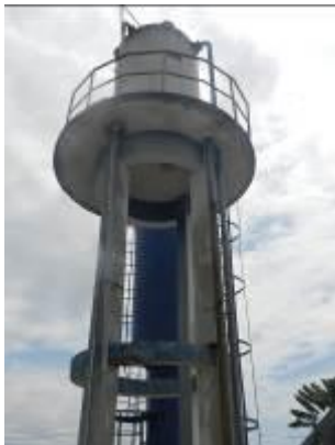
Figura 13 - Reservatório elevado da ETA
