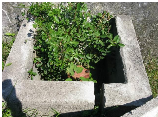
Figura 34 - Caixa de inspeção no Reservatório Barra do Jucu.
