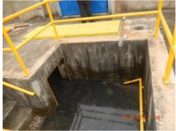
Figura 51 - Transbordamento no poço de entrada da elevatória João Goulart 01
