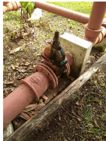
Figura 222 - Vazamento na válvula de descarga do reator UASB da ETE Vale Encantado.
