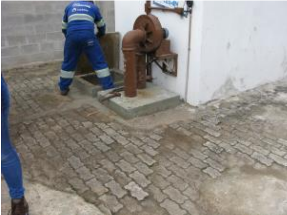
Figura 164 - Biofiltro inoperante na EEEB Parque das Gaivotas.
