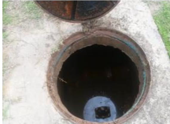
Figura 118 - Líquido retido em caixa EEEB B / Prainha.
