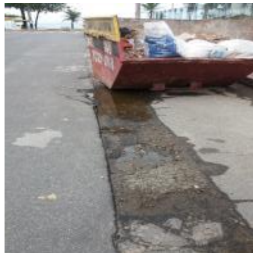
Figura 225 - Abaulamento do Asfalto em vários trechos da Rua Itapemirim, Bairro Praia de Itaparica. Fonte Prefeitura Municipal de Vila Velha.
