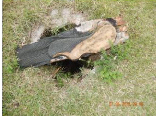
Figura 219 - Manilhas / Aberturas na área da ETE Vale Encantado.
