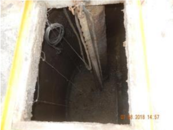
Figura 173 - Excesso de sólidos grosseiros na EEEB D – Pimpolho
