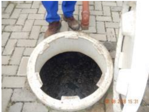
Figura 22 - Presença de sobrenadantes no reator anaeróbio compartmentado da ETE Mar D'Ulé
