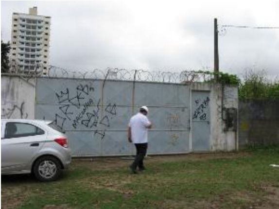
Figura 73 - Elevatória EEEB 1 – Guaranhus I, próximo ao Campo de Futebol e Centro Comunitário do SES Araças sem identificação.
