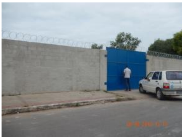
Figura 1 - ETE Jabaeté sem identificação.
