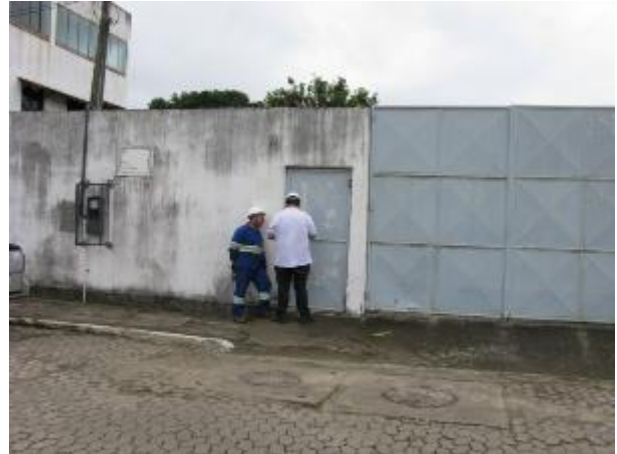
Figura 83 - Identificação da elevatória EEEB-02 – Guaranhus II do SES Araças deteriorada
