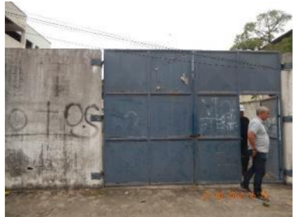
Figura 68 - Elevatória EEEB Q/ IBES do SES Araçás sem identificação.
