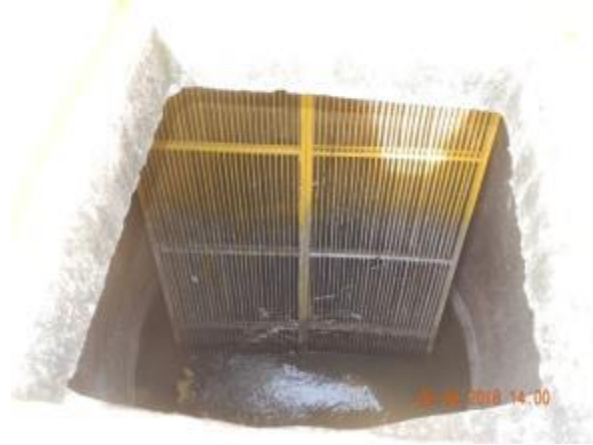
Figura 7 - Gradeamento sem função na elevatória Jabaeté III.
