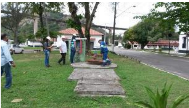
Figura 77 - Elevatória EEEB Exército do SES Araças sem identificação.
