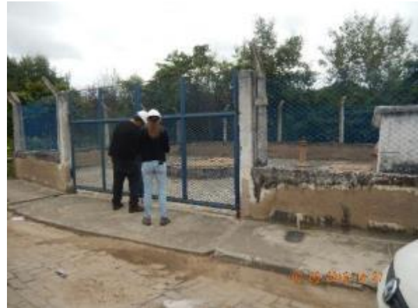
Figura 66 - Elevatória Dom João Batista sem identificação.
