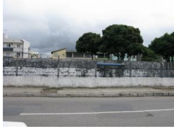
Figura 197 - Ausência de sinalização da unidade desativada.
