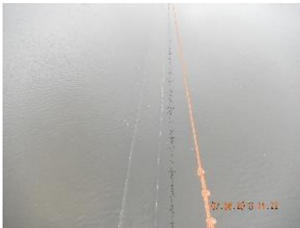
Figura 191 - Calha do desarenador afogada na ETE Araçás.
