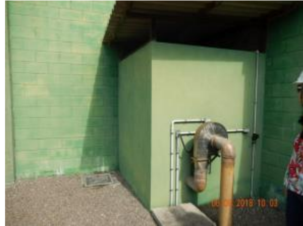
Figura 32 - Biofiltro existente sem funcionamento na EEEB C do sistema Riviera Park.
