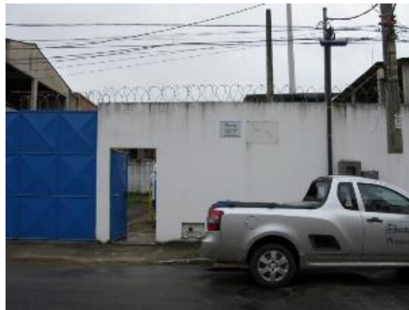
Figura 79 - Identificação da elevatória EEEB 5 do SES Araças deteriorada
