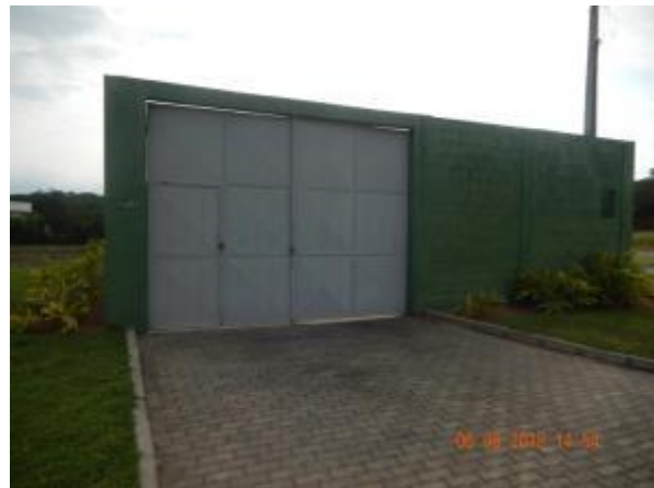
Figura 16 - Elevatória 01 do Sistema Jardins Veneza sem identificação.
