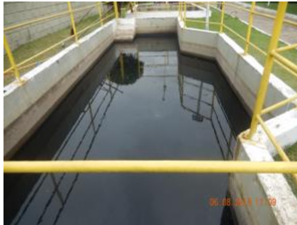
Figura 56 - Gradeamento não visível na ETE Ulisses Guimarães.
