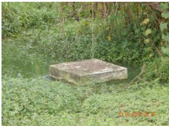
Figura 221 - Vazamento do poço de visita antes do lançamento e próximo à tubulação de drenagem pluvial.
