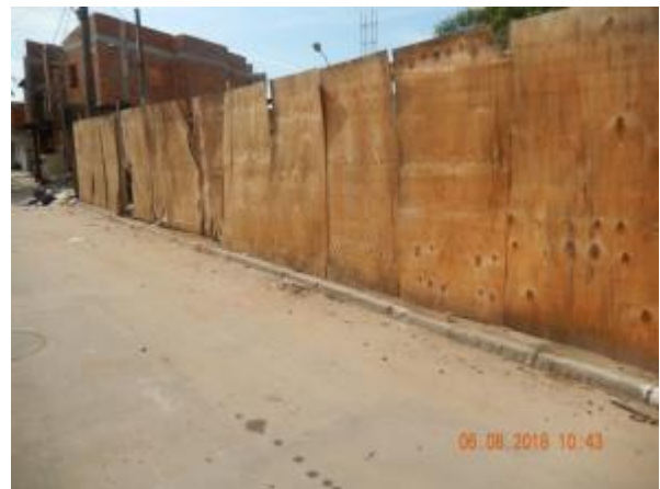
Figura 39 - Elevatória Ulisses Guimarães II / Terra Vermelha 01 sem identificação.
