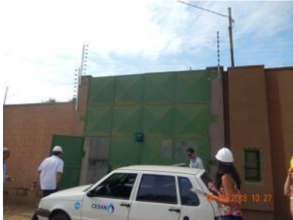
Figura 30 - Elevatória EEEB D do sistema Riviera Park não identificada.
