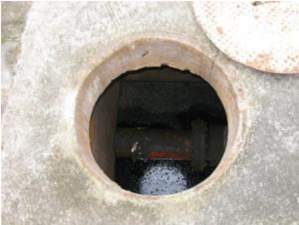
Figura 119 - Líquido retido em caixa EEEB Itaparica.
