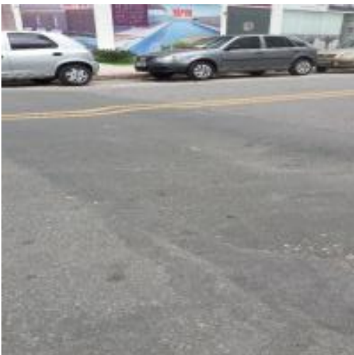
Figura 225 - Abaulamento do Asfalto em vários trechos da Rua Itapemirim, Bairro Praia de Itaparica. Fonte Prefeitura Municipal de Vila Velha.
