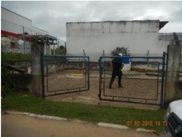
Figura 65 - Elevatória Colinas II sem identificação.
