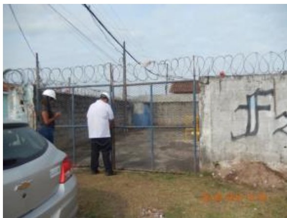
Figura 3 - Elevatória Jabaeté III sem identificação.
