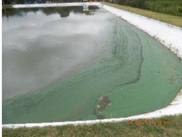
Figura 217 - Excesso de sobrenadantes em áreas próximas aos taludes na ETE Vale Encantado.
