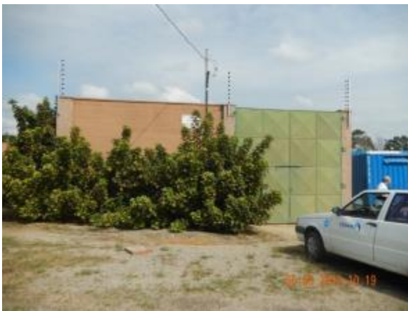
Figura 28 - Elevatória EEEB A do sistema Riviera Park não identificada.
