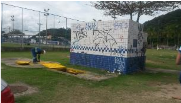
Figura 75 - Elevatória EEEB B Prainha do SES Araças sem identificação.
