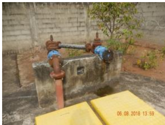
Figura 10 - Tubulação de sucção retirada na Elevatória Jabaeté III.
