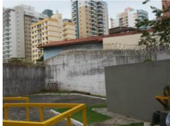
Figura 165 - Biofiltro inoperante na EEEB C Terceira Ponte
