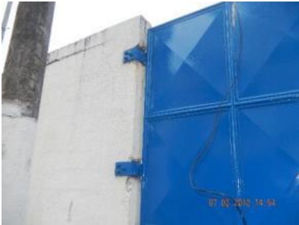
Figura 67 - Elevatória EEEB D / Pimpolho do SES Araçás sem identificação.
