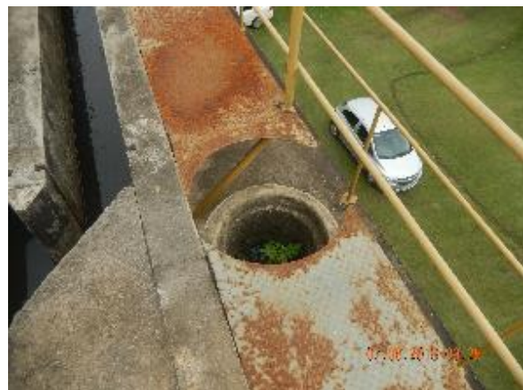
Figura 212 - Plataforma metálica superior com interrupção.
