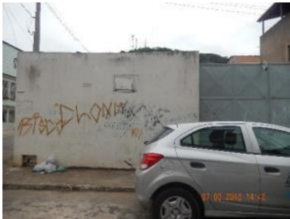
Figura 78 - Identificação da elevatória EEEB R do SES Araças deteriorada.
