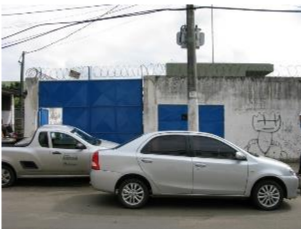
Figura 71 - Elevatória EEEB J - Itapoã do SES Araçás sem identificação.
