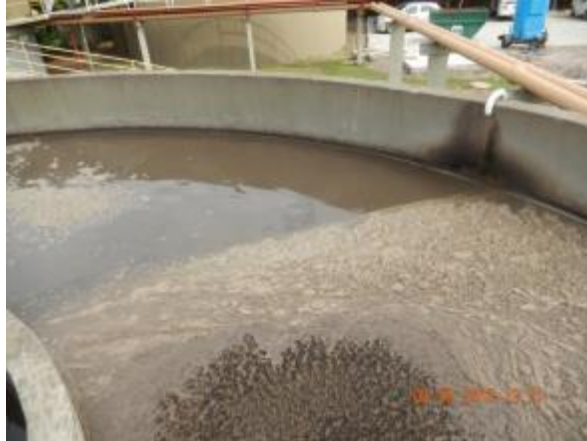
Figura 13 - Presença de sobrenadantes nos tanques de aeração na ETE Jabaeté.
