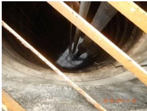
Figura 53 - Material passante devido a retirada do gradeamento na elevatória Ulisses Guimarães I / Terra Vermelha 02.
