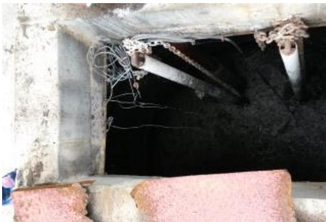
Figura 170 - EEEB Exército sem Gradeamento.
