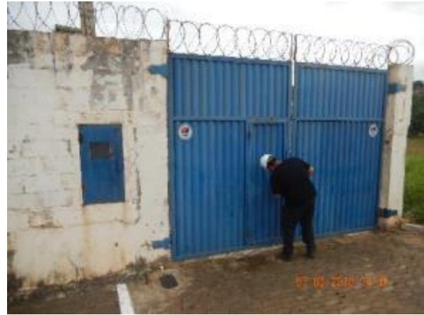
Figura 64 - Elevatória Colinas I sem identificação.
