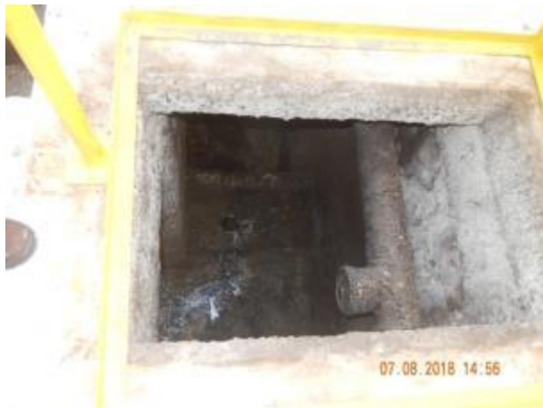
Figura 168 - EEEB D – Pimpolho sem Gradeamento.
