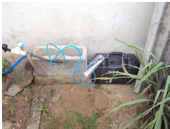
Figura 8 - Instalação do Equipamento no Ponto 08 - Município de Vila Velha, ES
