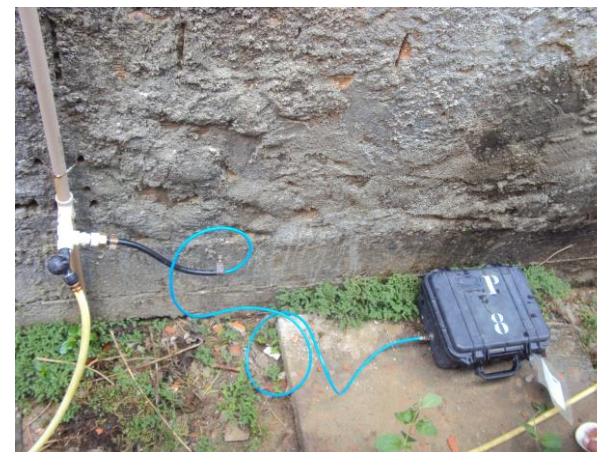
Figura 3 - Instalação do Equipamento no Ponto 03 - Município de Vila Velha, ES
