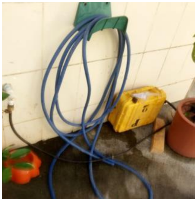
Figura 2 - Equipamento de medição instalado no Ponto 02 - Município de Vila Velha, ES
