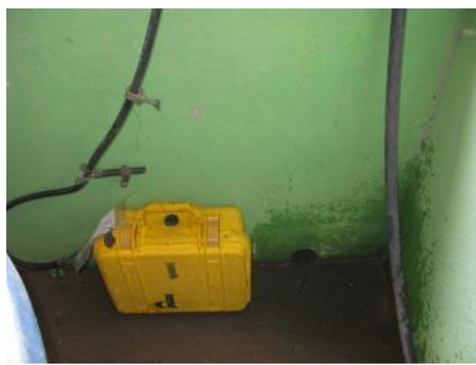
Figura 12 - Equipamento de medição instalado no Ponto 11 – Município de Vila Velha, ES
