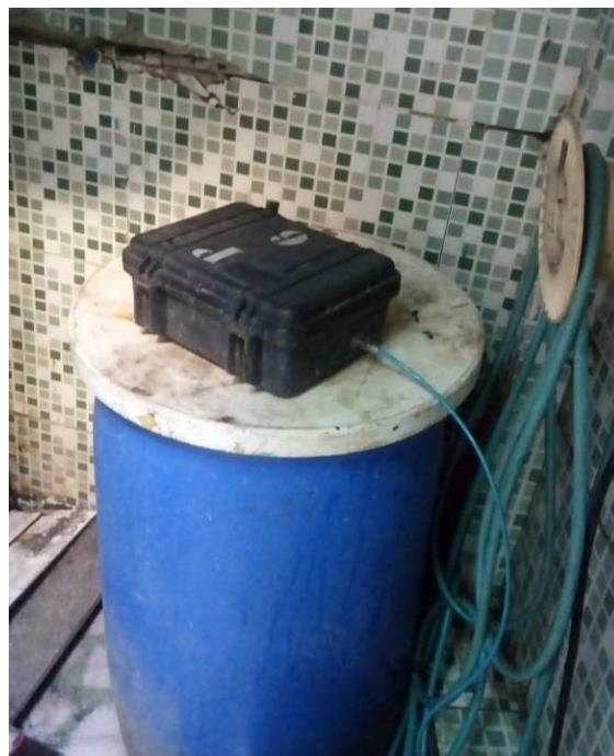
Figura 6- Equipamento de medição instalado no Ponto 06 – Município de Vila Velha, ES
