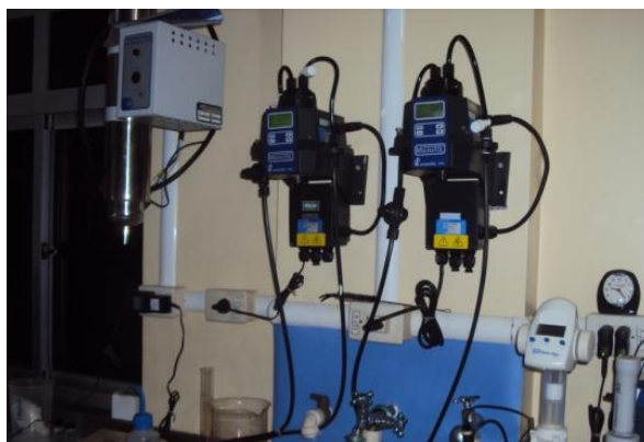
Figura 33 – Leitores de turbidez “on line” da água bruta e após o tanque de contato.
