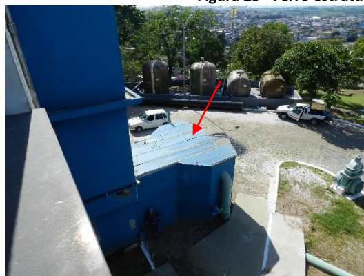
Figura 26 - Tanque de contato.
