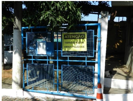
Figura 16 - Sinalização no portão de entrada da ETA Cobi.
