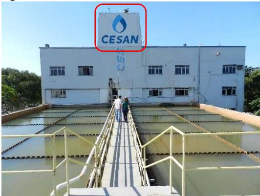
Figura 22 – Decantadores e reservatório elevado.
