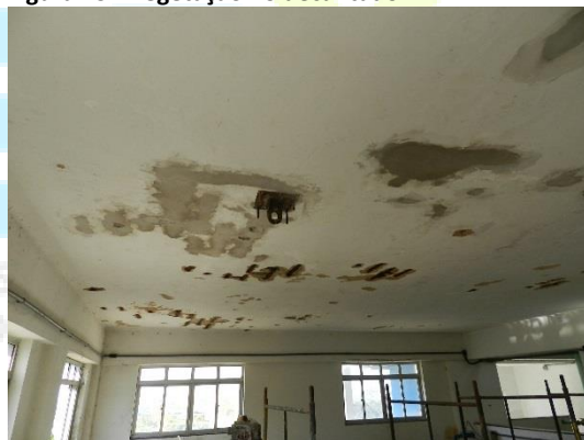
Figura 25 - Ferro estrutural exposto no teto.
