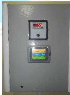
Figura 37 - Medidor de vazão.
