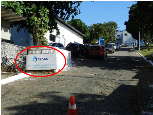
Figura 15 - Identificação da ETA Cobi.
