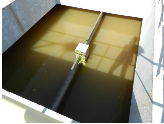
Figura 21 – Vegetação no floculador.
