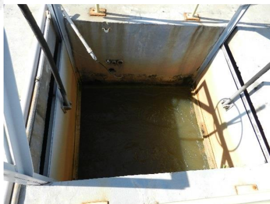
Figura 18 - Unidade de mistura rápida desativada.
