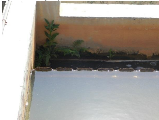
Figura 23 - Vegetação no decantador.
