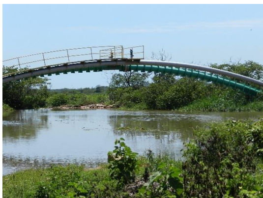
Figura 1 - Local onde está instalado o barramento de nível do rio Jucu.
