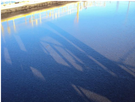
Figura 3: Excesso de lodo nos reatores
