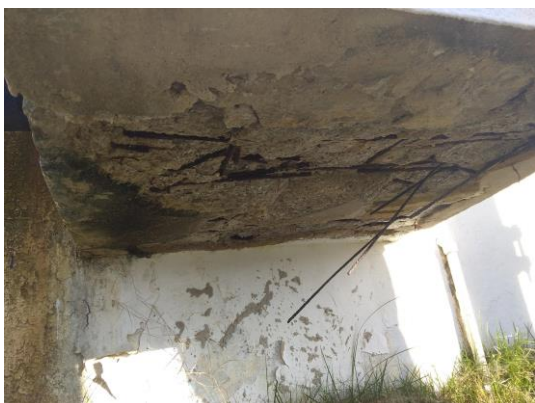
(a) Caixa de passagem ao lado do Filtro na ETA.
