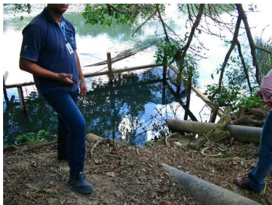
Figura 4: Ausência de sinalização do ponto de captação no Rio São José
