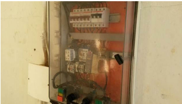
Figura 15: Conjunto de controles e proteção elétrico sem identificação e placa de Risco de Choque elétrico na ETA Vila Valério (C.11.3).
