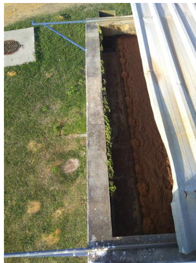
Figura 21: Crescimento de vegetação no tanque de flotação da ETA Vila Valério.
