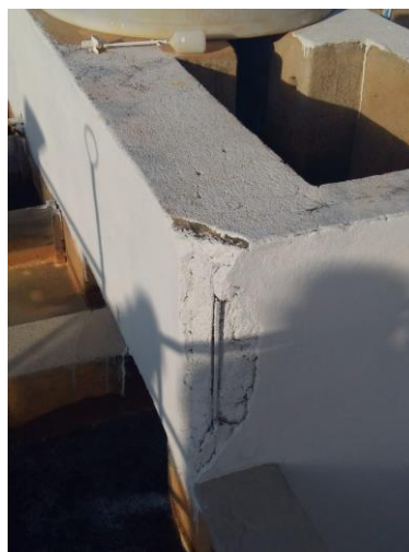
(b) Caixa de chegada de água bruta da ETA.
