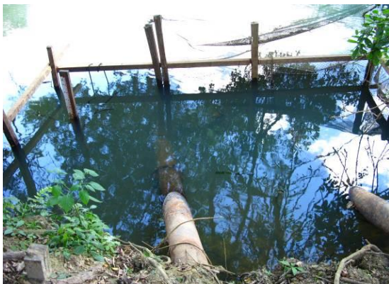
Figura 3: Proteção incipiente do ponto de captação de água bruta do Rio São José.
