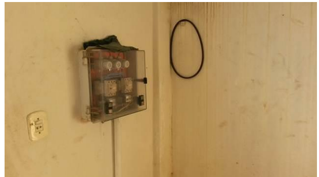
Figura 15: Conjunto de controles e proteção elétrico sem identificação e placa de Risco de Choque elétrico na ETA Vila Valério (C.11.3).
