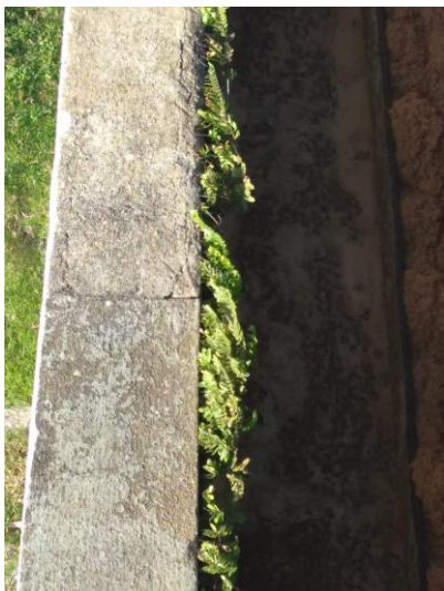
Figura 21: Crescimento de vegetação no tanque de flotação da ETA Vila Valério.
