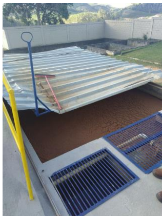
Figura 10: Telhado móvel do flutuador da ETA danificado.
