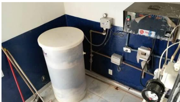
Figura 18: Ausência de lava olhos e chuveiro de emergência nas áreas de risco da ETA de Vila Valério
