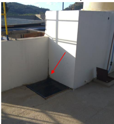
Figura 19: Pontos de infiltração da ETA de Vila Valério.
