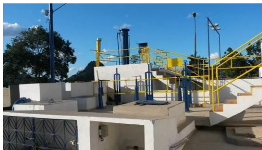
Figura 11: Ausência de tomada de água na saída de cada filtro na ETA.
