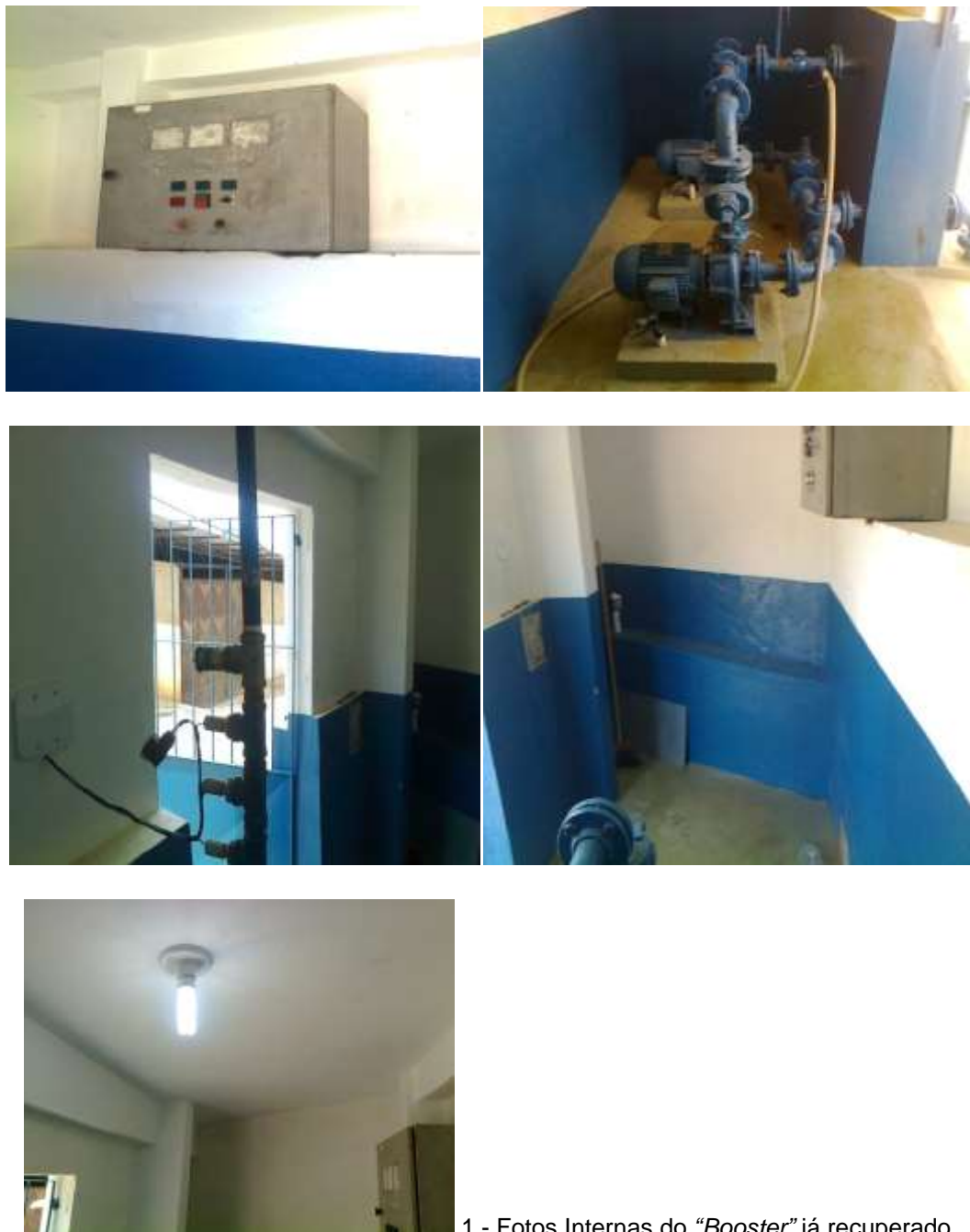
1 - Fotos Internas do “Booster” já recuperado.
