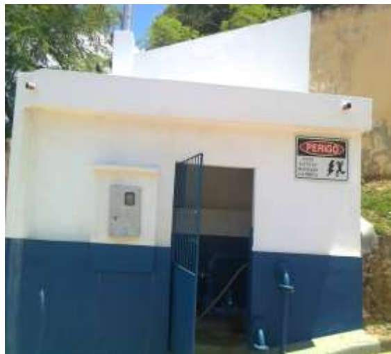
2 - Fotos Externas do "Booster" já recuperado.
