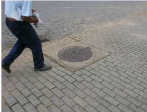
Figura 21 - Tampa de esgoto.
