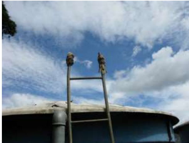
Figura 20 - Escada de acesso .
