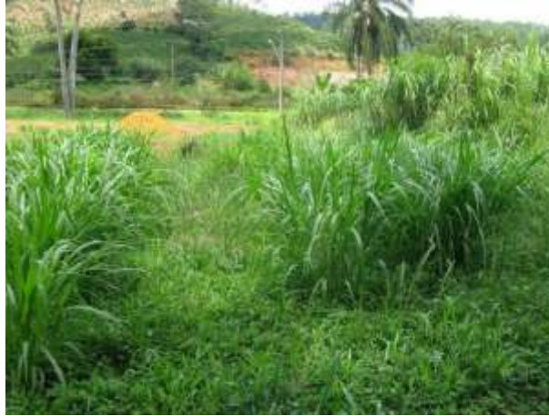
Figura 16 - Ausência de cercamento na ETE Bicuíba
