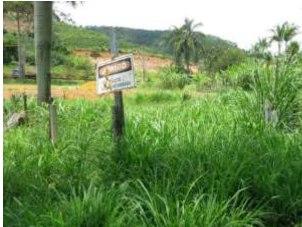
Figura 15 - Excesso de vegetação na ETE Bicuíba
