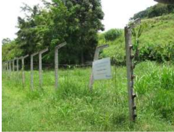
Figura 19 - ETE de São João de Viçosa
