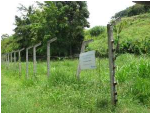
Figura 18 - ETE de São João de Viçosa
