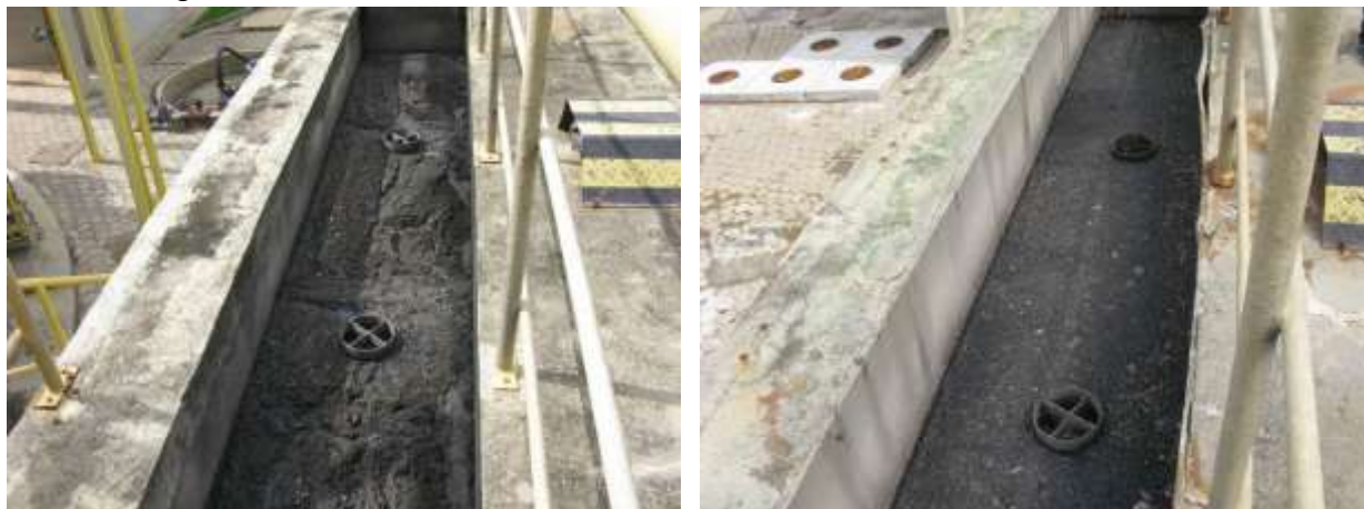
Figura 10 – Tanque do UASB da ETE de Venda Nova do Imigrante
