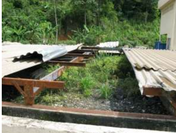
Figura 13 - Leitos de secagem da ETE Venda Nova do Imigrante
