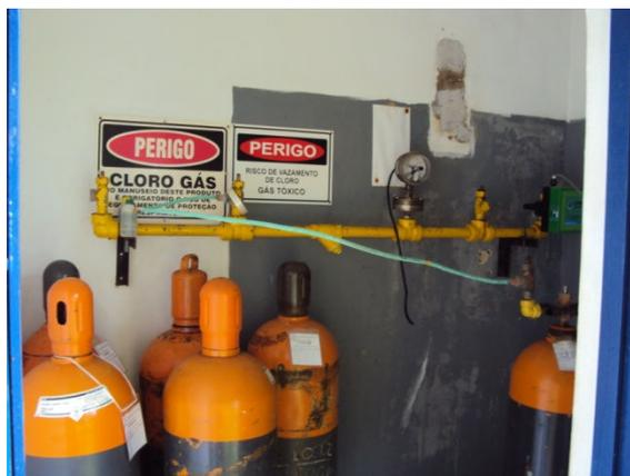
Figura 14: Armazenamento de cloro gasoso
