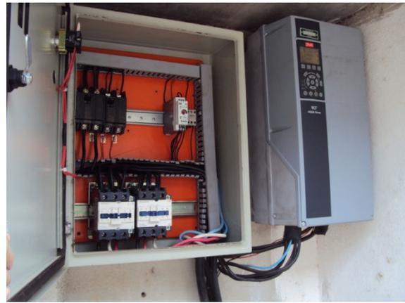
Figura 26: Quadro de Força e Inversor de Frequência da Estação Elevatória de Esgoto Bruto I
