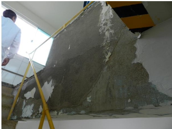
Figura 4 - ETA de São José do Calçado.
