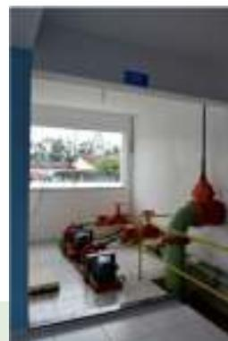
Figura 43: Conjunto motor-bomba da EEAT do Reservatório Elevado.
