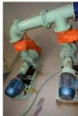
Figura 41 - Conjunto motor bomba da EEAT do reservatório semi-enterrado.
