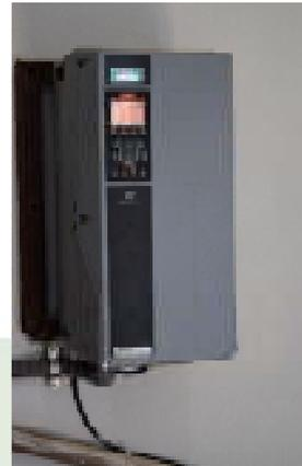
Figura 59 - Inversor de frequência do booster Sizenando Viana.
