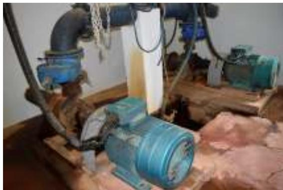
Figura 6 - Conjunto motor-bomba.
