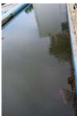
**Figura 20: Presença de lodo nas laterais e na superfície dos decantadores.**
