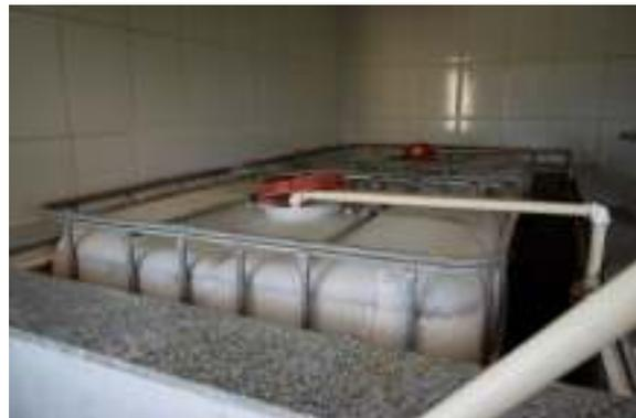
Figura 27: Armazenamento de sulfato de alumínio.
