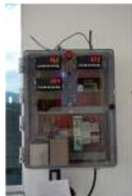
Figura 47 – Sistema de controle de nível do reservatório semi-enterrado.
