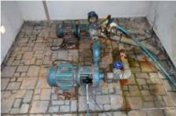
Figura 58 - Conjunto Motor-Bomba do Booster Sizenando Viana.
