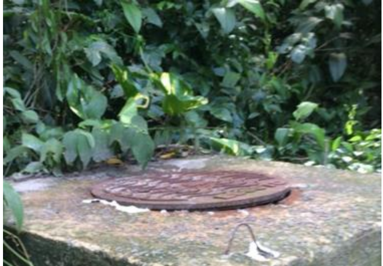
Figura 5 – Tampas dos PV's da Rede de Esgoto da EEEB Europa.
