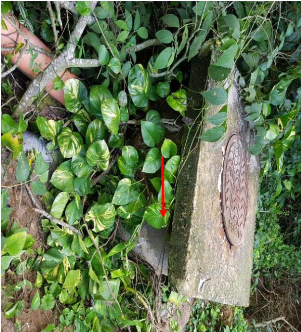
Figura 7 – Tubulação e PV da rede de esgoto ligada a EEEB Europa.
