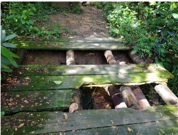
Figura 2 – Acesso aos PV's da rede de esgoto ligada a EEEB Europa.
