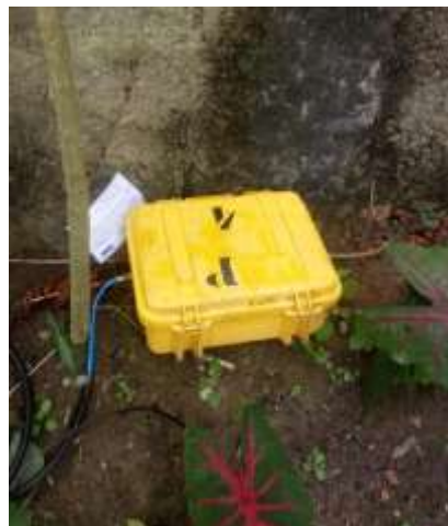
Figura 13 - Equipamento de medição instalado no Ponto 13 - Município da Serra, ES
