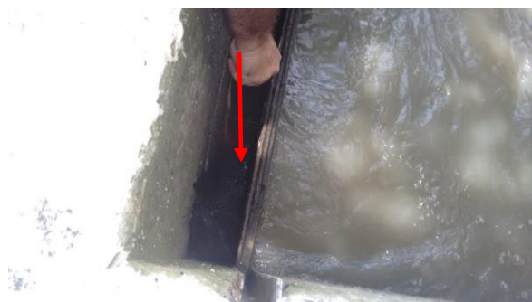
Figura 1 - Comporta existente no tratamento preliminar da ETE Nova Carapina, contendo vazamento de esgoto bruto. O traçador foi lançado neste local.
