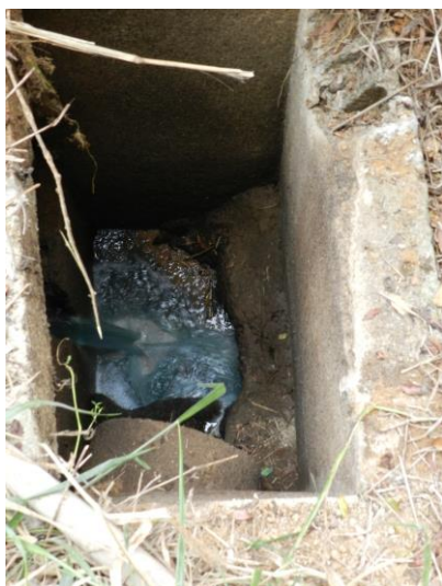
Figura 7 - Local de lançamento do efluente com traçador azul proveniente da caixa de passagem no emissário final.
