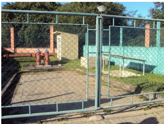
Figura 14 - Entrada da EEBB E sem identificação.
