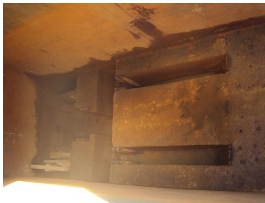
Figura 7 – Gradeamento e caixa de areia da EEBB I.
