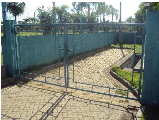
Figura 6 - Entrada da EEBB I sem identificação.
