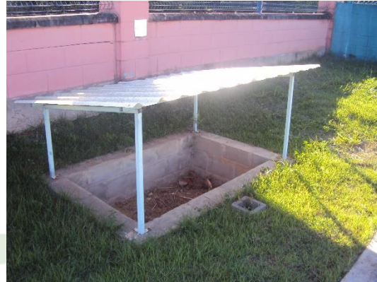
Figura 27 – Biofiltro da EEB F.
