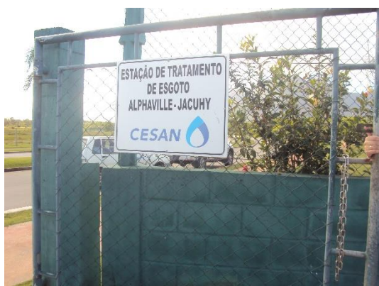
Figura 29 - Entrada da ETE Alphaville Jacuhy identificada.
