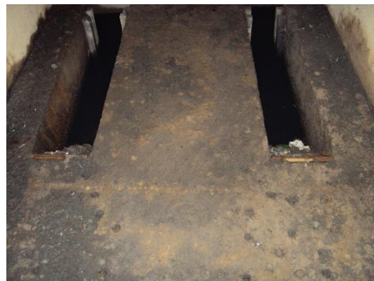
Figura 15 – Gradeamento e caixa de areia da EEBB E.
