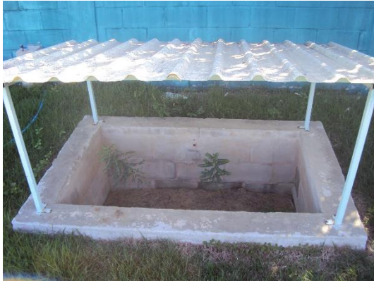
Figura 12 – Biofiltro da EEBB H.
