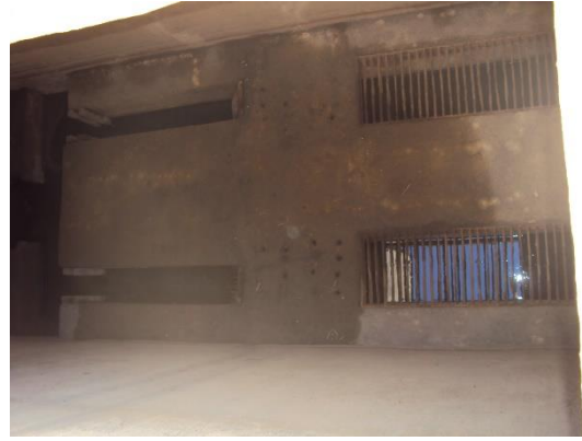
Figura 11 – Gradeamento e caixa de areia da EEBB H.
