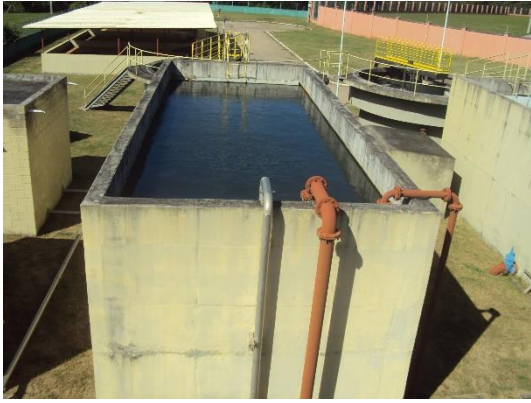
Figura 31 – Aerador da ETE Alphaville Jacuhy.
