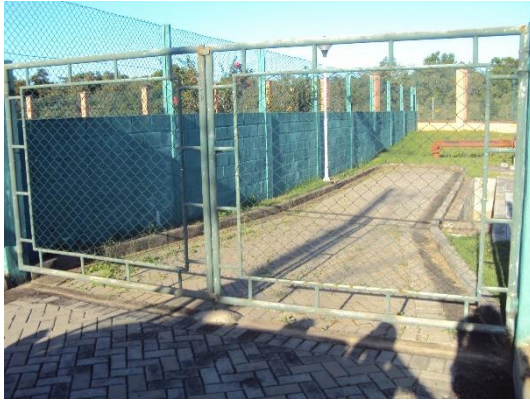
Figura 19 - Entrada da EEB D sem identificação.
