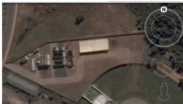
Figura 1 - Vista aérea da ETE Alphaville Jacuhy.
