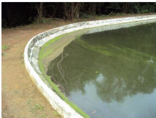
Figura 28 - Sobrenadante na lagoa facultativa da ETE Nova Carapina.
