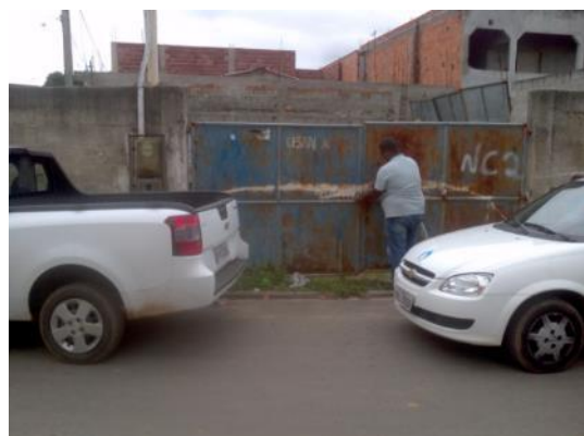
Figura 37 - Ausência de identificação na EEEB Cidade Pomar.
