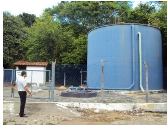
Figura 63 - Reator UASB sem acesso da ETE Eldorado.
