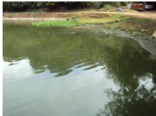
Figura 61 - Assoreamento e macrófitas na lagoa facultativa da ETE Eldorado.
