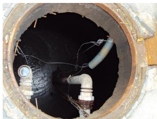
Figura 48- Poço de sucção da EEEB Novo Porto Canoa IV.
