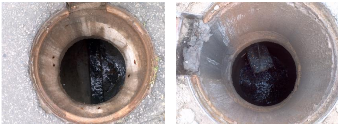
Figura 4- Poços de Visita (PV's) vistoriados na Rua Teófilo Otoni, no Sistema de Esgotamento Sanitário Nova Carapina.
