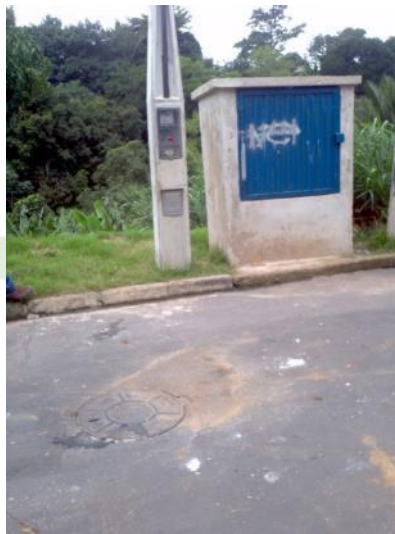
Figura 23 - EEEB Andrelândia sem identificação.
