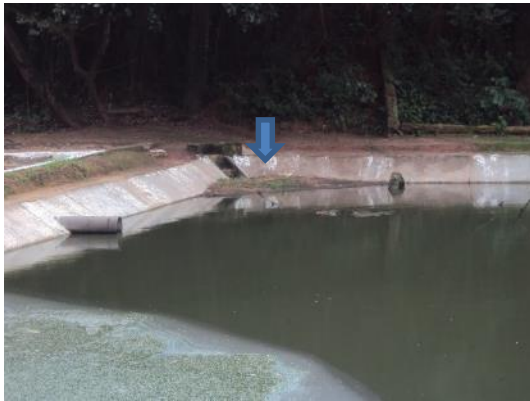
Figura 58 - Lagoa anaeróbia assoreada da ETE Eldorado.
