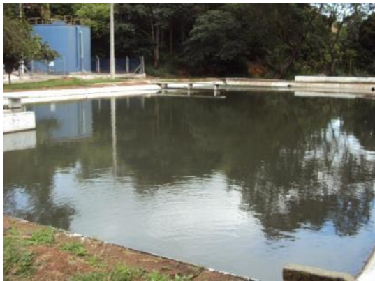
Figura 52 - Lagoa anaeróbia e reator UASB da ETE Eldorado.
