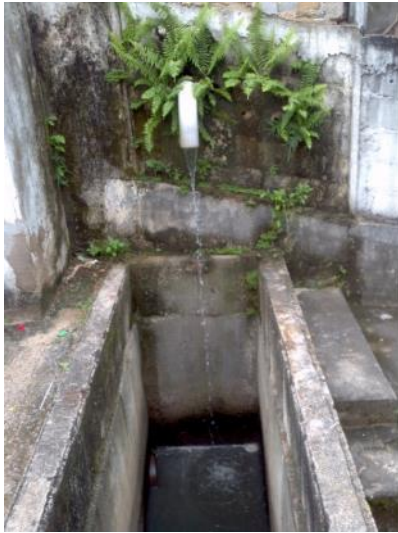
Figura 13 - Ligeira irregular no gradeamento da EEB Nova Carapina II.
