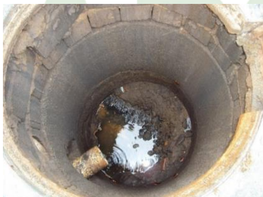
Figura 35 - Poço de Visita – Rua Palmeiras.
