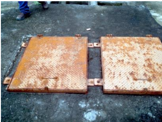
Figura 15 - Tampas do poço de sucção da EEB Nova Carapina II.
