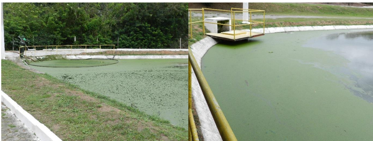
Figura 2 - Presença de sobrenadantes e macrófitas na lagoa facultativa da ETE Eldorado.
