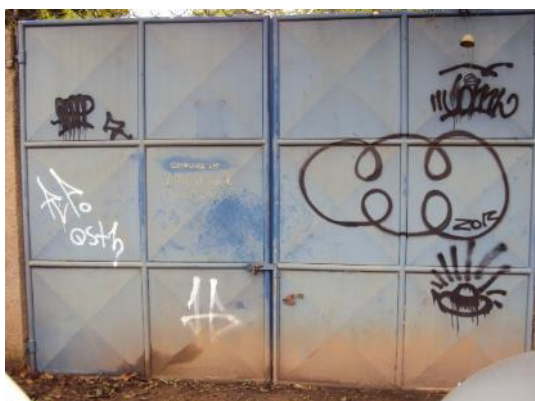
Figura 43 - Entrada sem identificação da EEBB Arquipélago de Manguinhos 6.
