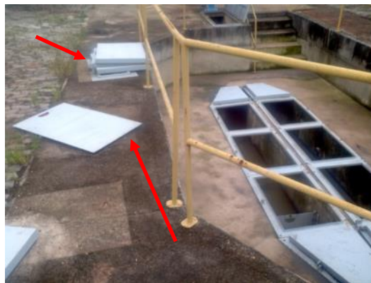
Figura 25 - Tampas da caixa de areia da EEBB Rossi Vilas do Mar dispostas ao lado da mesma.
