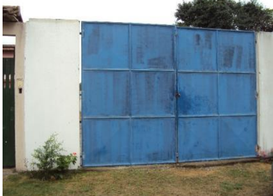
Figura 38 - Entrada sem identificação da EEEB M-2.
