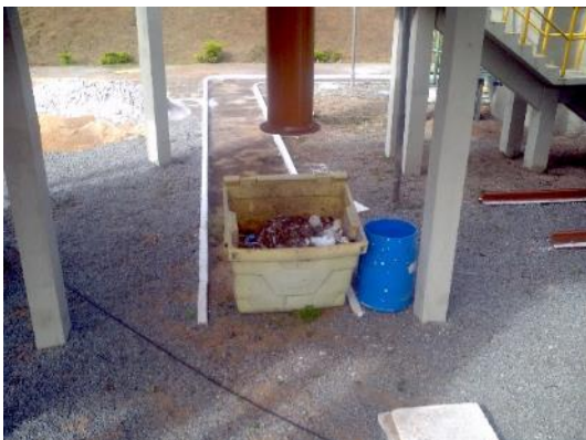
Figura 74 - Armazenamento dos resíduos do tratamento preliminar da ETE Manguinhos.
