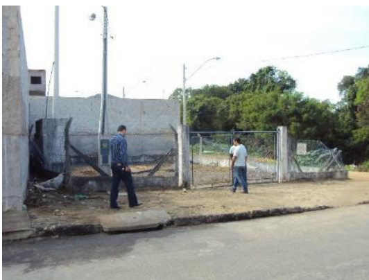
Figura 54 - Entrada sem identificação da EEEB Ásia.
