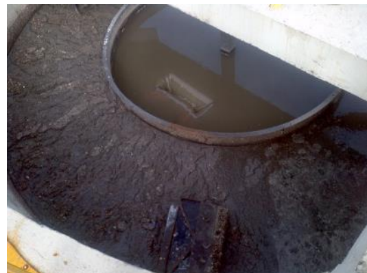
Figura 75 - Mecanismo de remoção de gordura inoperante da ETE Manguinhos.
