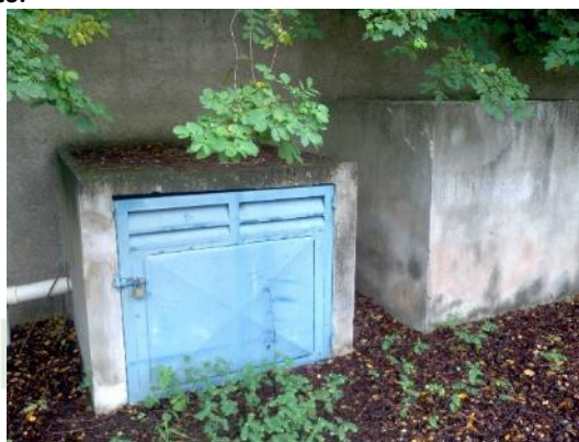
Figura 13 – Biofiltro da EEBB Arquipélago de Manguinhos 2.
