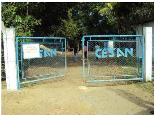
Figura 64 - Entrada com identificação deficiente da EEBB Cidade Continental.
