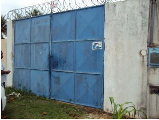
Figura 32 - Entrada sem identificação da EEEB-M-1.
