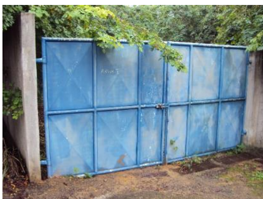
Figura 5 - EEB Arquipélago de Manguinhos 1 sem identificação.
