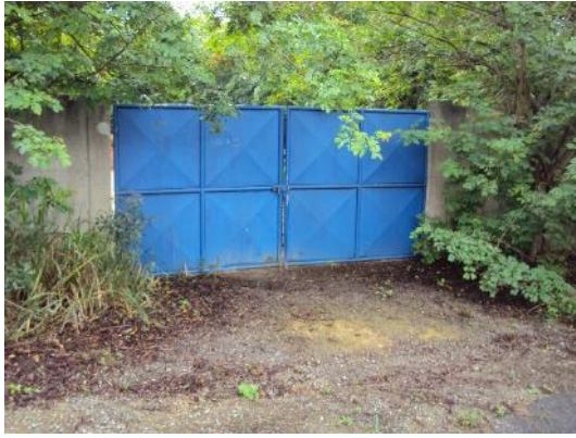
Figura 14 - Entrada sem identificação da EEBB Arquipélago de Manguinhos 3.
