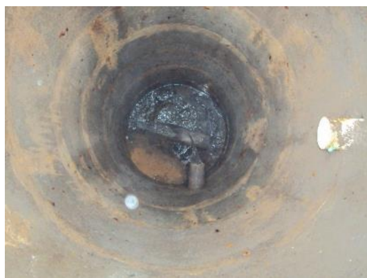
Figura 4 – Poço de visita vistoriado do SES Manguinhos.
