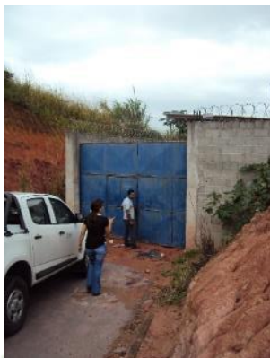
Figura 20 - Entrada sem identificação da EEBB Rossi Vilas do Mar.
