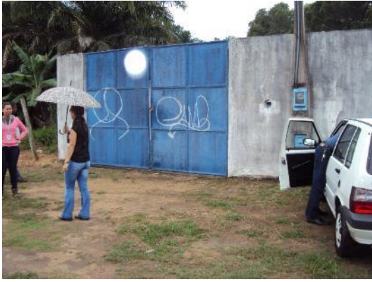
Figura 28 - Entrada sem identificação da EEBB M-5.
