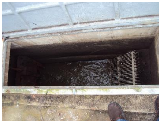
Figura 21 – Gradeamento da EEBB Rossi Vilas do Mar.
