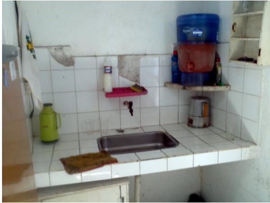
Figura 15 – Casa de apoio aos operadores da ETE Laranjeiras.
