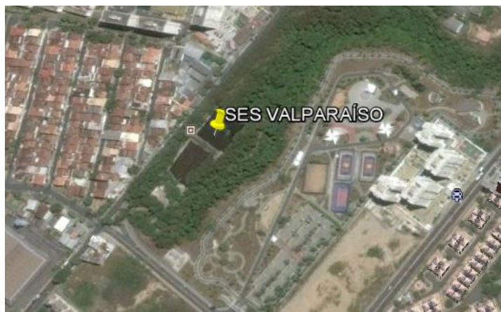
Figura 17 - Vista aérea da ETE Valparaíso.
