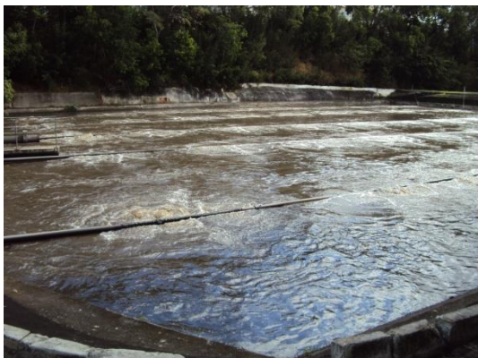
Figura 30 - Lagoa aerada de mistura completa da ETE Valparaíso.
