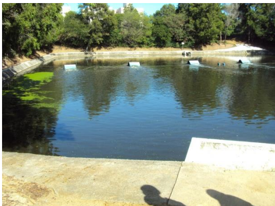
Figura 11 - Lagoa facultativa da ETE Laranjeiras com aeradores.
