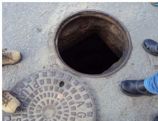
Figura 5 - PV vistoriado do Sistema Laranjeiras. Detalhe para a identificação da tampa de "Águas Pluviais".
