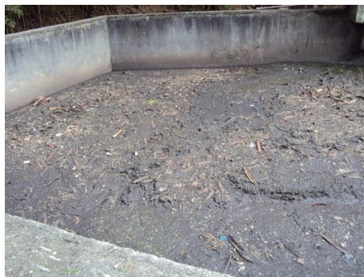
Figura 39 - Primeiro leito e secagem da ETE Valparaíso.
