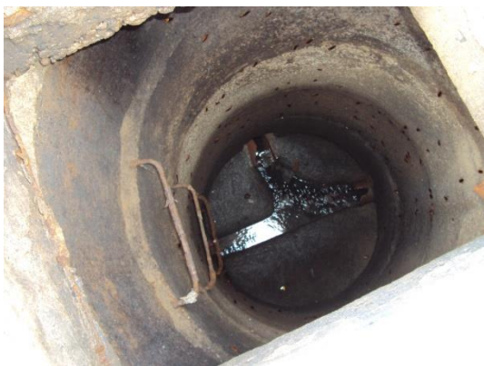
Figura 4 - PV vistoriado na Avenida Central de Laranjeiras, Sistema Laranjeiras .
