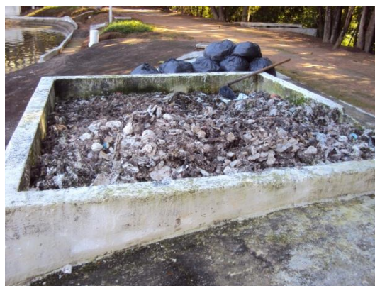
Figura 8 - Caixa de resíduos do gradeamento da ETE Laranjeiras.
