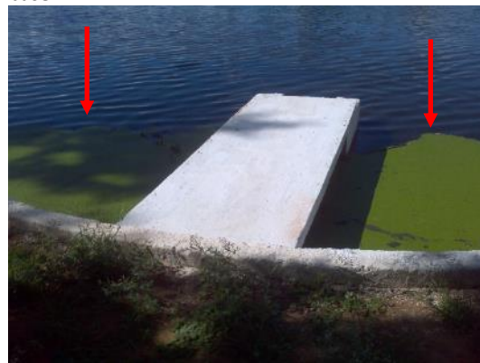
Figura 33 - Macrófitas na superfície da lagoa facultativa da ETE Jardins.
