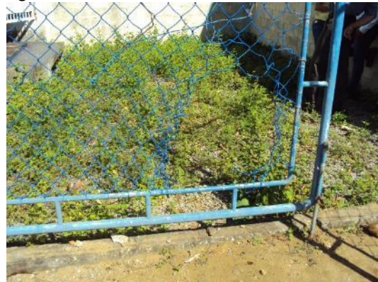
Figura 73 - Portão de entrada com abertura e vegetação na área interna.
