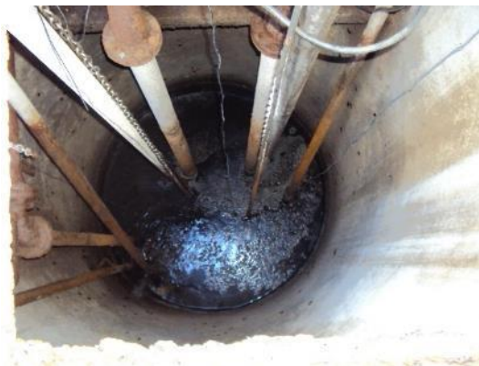
Figura 48 - Poço de sucção da EEEB Coral Direita com resíduos grosseiros.
