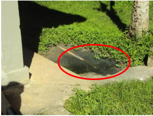
Figura 87- Vazamento de esgoto no solo próximo à lagoa anaeróbia da ETE Serra Dourada.
