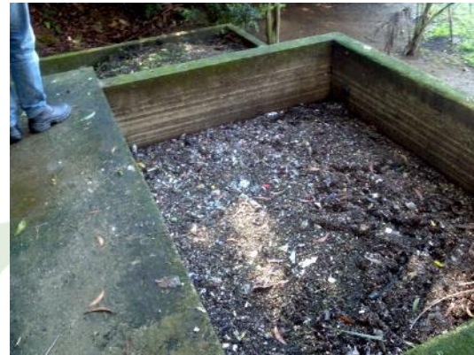
Figura 90 - Caixa de resíduos da ETE Serra Dourada.
