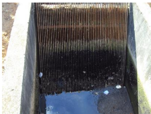
Figura 13 - Gradeamento da EEBB Jardim Bela Vista.
