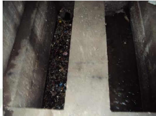
Figura 71 - Caixa de areia da EEB Porto Canoa II.
