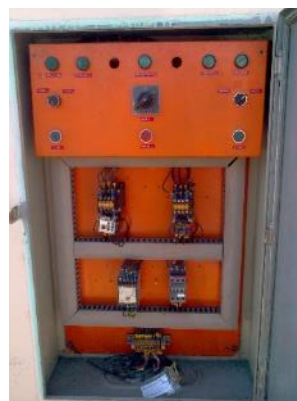
Figura 50 - Painel de controle da EEEB Coral Esquerda.
