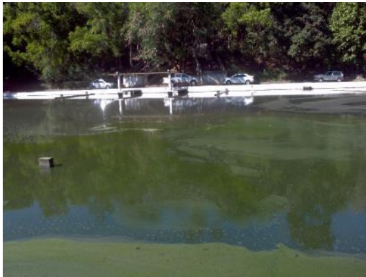
Figura 89 - Lagoa facultativa da ETE Serra Dourada com excesso de sobrenadante.
