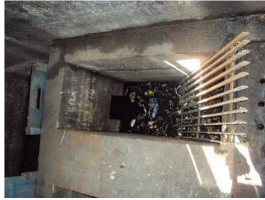
Figura 69 - Gradeamento da EEB Porto Canoa II.
