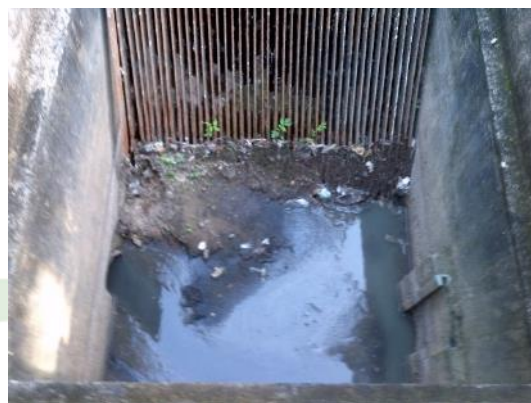
Figura 19 - Gradeamento da EEEB Jardim Primavera.
