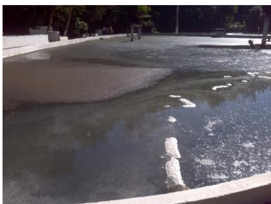
Figura 85 - Lagoa anaeróbia da ETE Serra Dourada com excesso de lodo e fluxo direcional preferencial.
