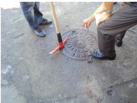
Figura 44 - Poço de visita com identificação.
