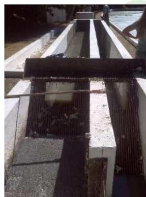
Figura 84 - Segundo tratamento preliminar da ETE Serra Dourada.
