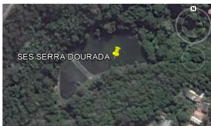
Figura 41 - Vista aérea da ETE Serra Dourada.
