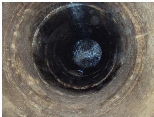
Figura 45 - Poço de visita sem obstrução.
