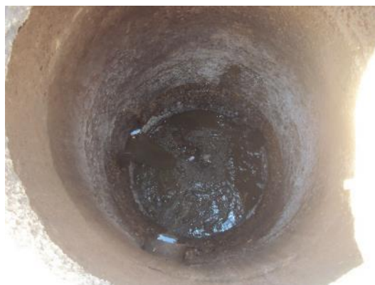
Figura 5 - Poço de visita em condições satisfatórias.
