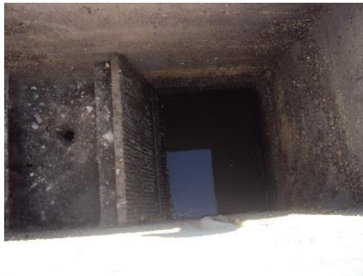
Figura 13 - Gradeamento da EEB Jacaraípe Velha I.
