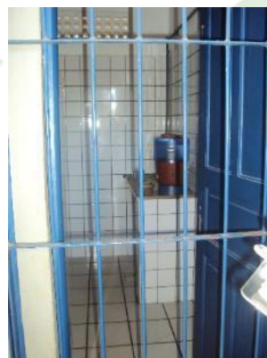
Figura 53 – Casa de apoio dos operadores.
