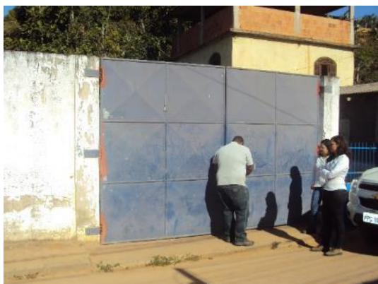
Figura 80 - Entrada da EEBB NA 02 sem identificação.
