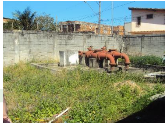
Figura 11 – Área interna da EEEB do Campo com excesso de vegetação.
