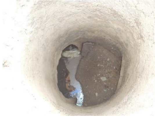
Figura 75 - Poço de visita desobstruído do SES Nova Almeida.
