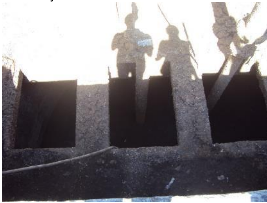
Figura 22 - Poço de sucção da EEB Jacaraípe Velha III sem tampas.
