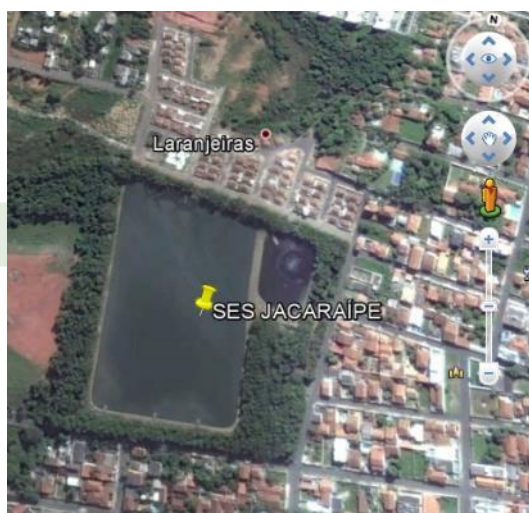
Figura 1 - Vista aérea da ETE Jacaraípe.
