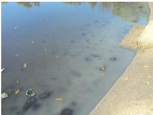
Figura 60 – Lagoa anaeróbia com excesso de lodo.
