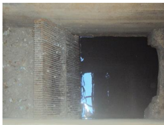
Figura 85 – Gradeamento da EEBB NA 03.
