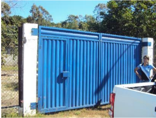
Figura 45 - EEEB Magistrados sem identificação.
