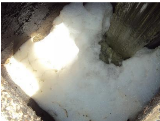
Figura 66 – Presença de espuma em uma das saídas da lagoa facultativa.
