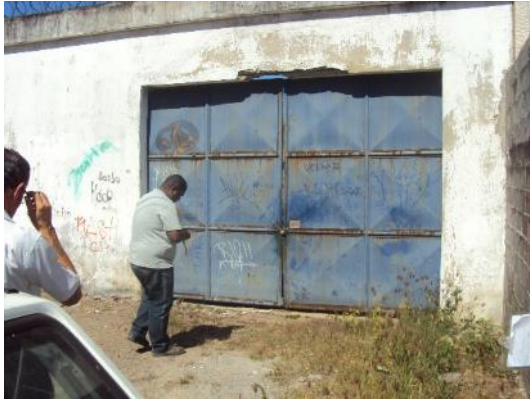
Figura 20 - Entrada da EEB Jacaraípe Velha III sem identificação.
