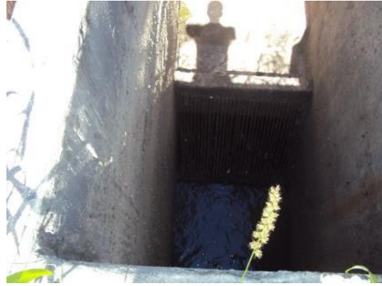
Figura 21 - Gradeamento da EEB Jacaraípe Velha III.
