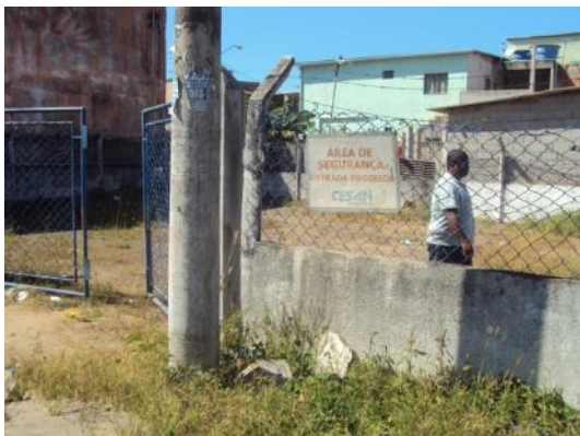
Figura 34 - EEEB São Paulo sem identificação.
