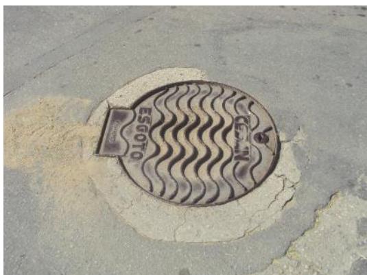
Figura 4 - Poço de visita com identificação.
