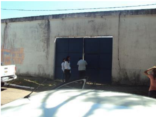
Figura 12 - Entrada da EEB Jacaraípe Velha I sem identificação.
