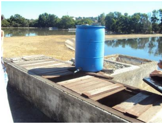
Figura 57 – B Q Bio sendo adicionado no preliminar.
