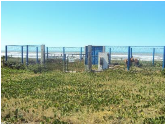
Figura 27 - Entrada da EEEB Carijós com identificação incompleta.
