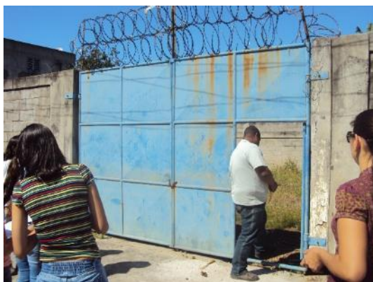
Figura 6 - Entrada da EEEB do Campo sem identificação.
