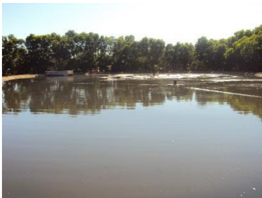
Figura 61 – Lagoa anaeróbia com dois aeradores.
