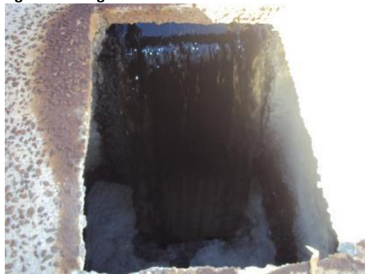
Figura 63 – Ponto intermediário na lagoa anaeróbia com espuma.
