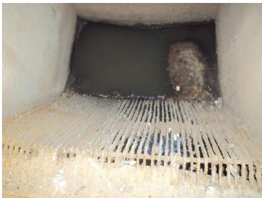
Figura 82 – Mecanismo de remoção de sólidos grosseiros demandando limpeza.
