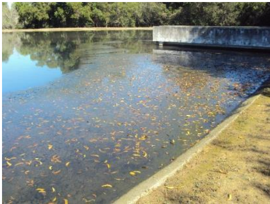
Figura 64 – Lodo e sobrenadante na lagoa facultativa.
