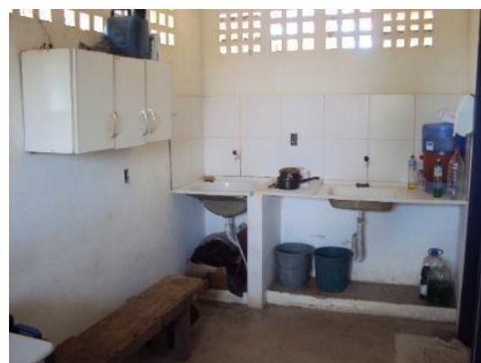
Figura 77 – Edificação de apoio para os operadores na ETE Furna.
