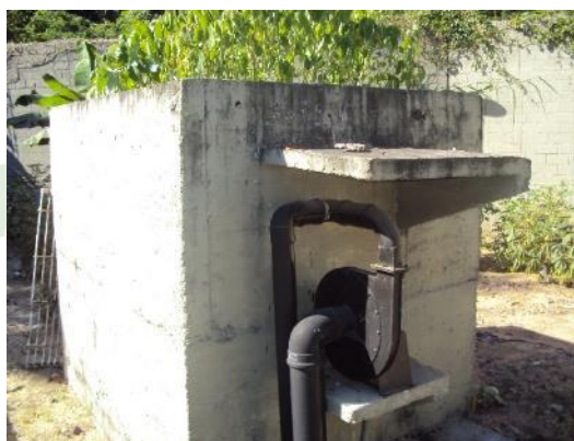
Figura 17 - Biofiltro da EEBB PB II inoperante.
