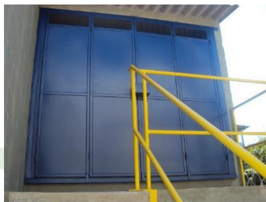
Figura 11 – Painel de controle sem sinalização de risco de choque elétrico na EEEB PB I.
