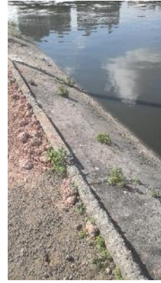
Figura 41 - Vegetação no talude interno da lagoa.
