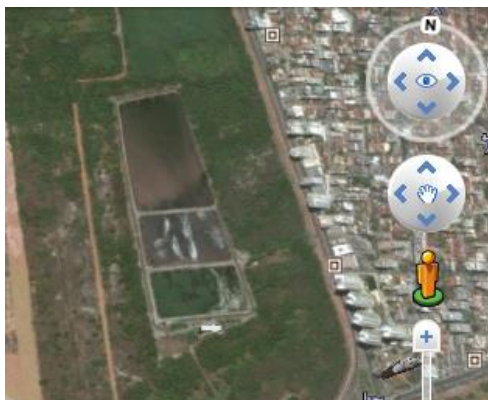
Figura 1 - Vista aérea da ETE Camburi.
