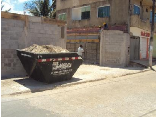
Figura 73 - EEBB Estados Unidos/Central Carapina sem identificação.
