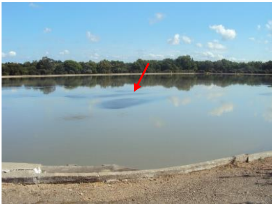
Figura 49 - Lagoa facultativa da ETE Jardim Camburi com pontos de assoreamento.
