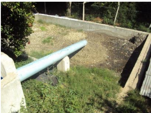
Figura 45 - Sobrenadante destinado no leito de secagem.
