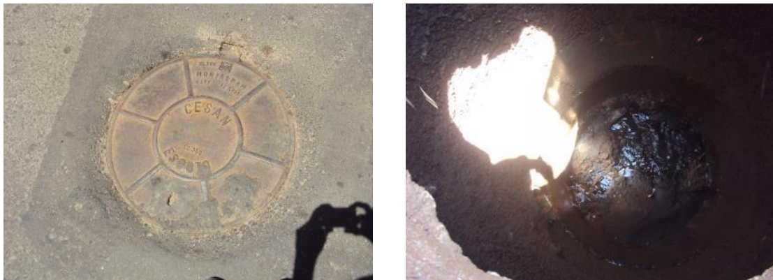
Figura 59- Poço de Visita (PV) vistoriado na Rua Estados Unidos, no SES Furnas.
