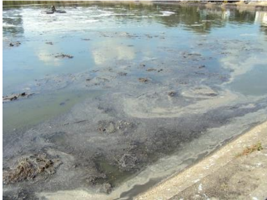
Figura 36 - Sólidos grosseiros, sobrenadantes, vegetação morta e macrófitas na primeira lagoa.
