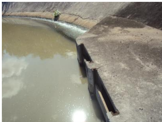
Figura 53 - Pontos de retirada de efluentes da lagoa facultativa para recirculação.
