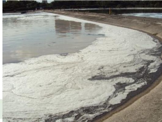
Figura 42 - Formação de espuma na segunda lagoa.
