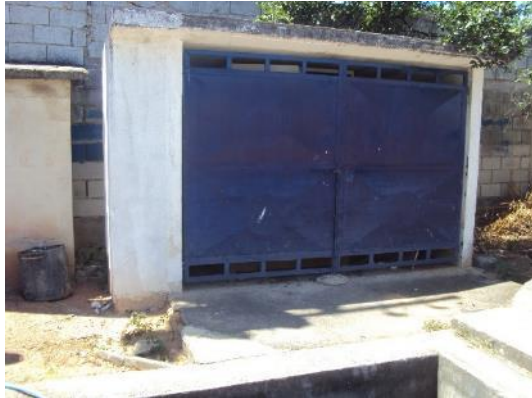
Figura 62 - Painel de controle da EEBB Furnas sem sinalização de risco de choque elétrico.
