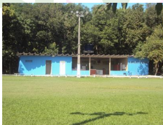
Figura 26 – Casa de apoio dos operadores.
