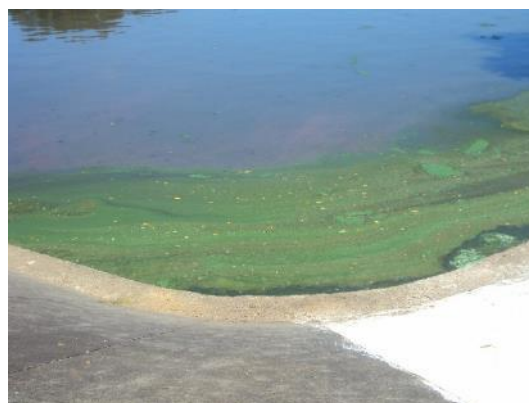
Figura 87 - Lagoa facultativa da ETE Furnas com sobrenadante.
