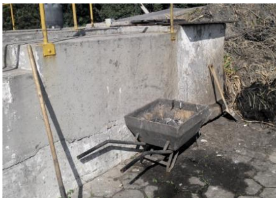
Figura 33 - Armazenamento improvisado dos sólidos grosseiros retirados do gradeamento e líquido drenado empossado no piso.
