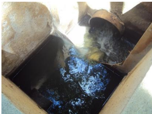
Figura 90 - Ponto de saída do efluente tratado.
