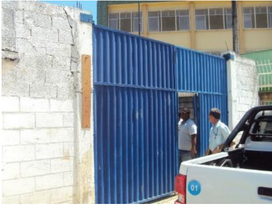
Figura 60 - Entrada da EEBB Furnas sem identificação.
