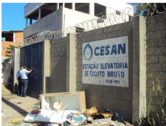
Figura 6 - Entrada da EEEB PB I com identificação.
