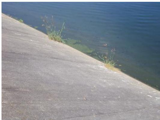
Figura 88 - Vegetação no talude da lagoa facultativa.
