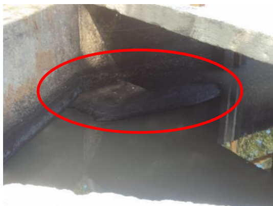
Figura 80 - Caixa de recepção de efluentes que antecede ao gradeamento da ETE Furnas.
