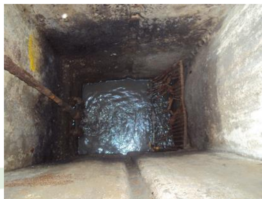
Figura 21 - Gradeamento da EEB Bairro de Fátima.
