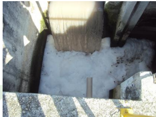
Figura 50 - Espuma presente nas saídas das lagoas aeradas.
