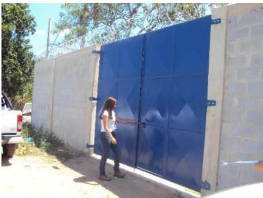
Figura 64 - Entrada da EEBB José de Anchieta sem identificação.
