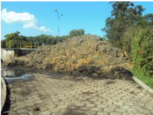
Figura 38 – Armazenamento de resíduos grosseiros de forma irregular no pátio da ETE.
