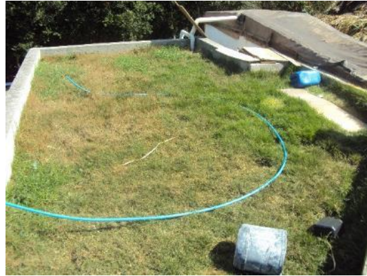
Figura 29 - Biofiltro do tratamento preliminar.
