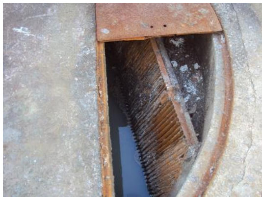
Figura 43 – Gradeamento da EEEB Portal de Manguinhos VI.
