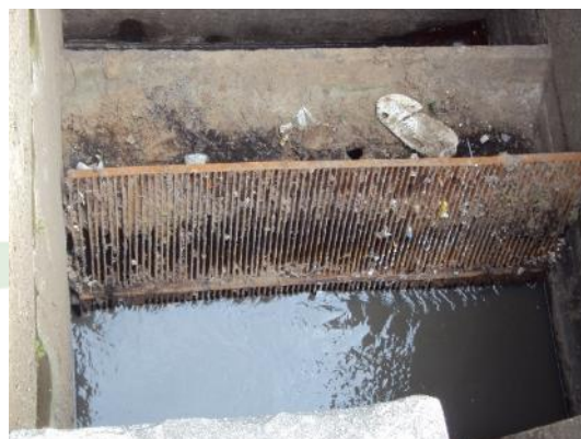
Figura 23 – Gradeamento da EEB Vila Nova de Colares II.
