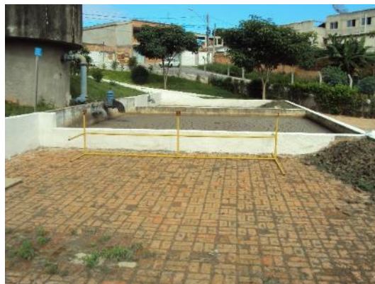
Figura 109 - Leito de secagem.
