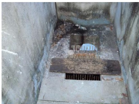
Figura 54 - Gradeamento da EEB Copacabana com tampa de madeira e resíduos.
