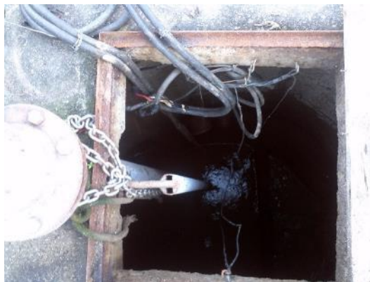
Figura 68 - Poço de sucção da EEB Colina de Laranjeiras I com fiação exposta.
