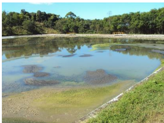
Figura 78 - Lagoa de polimento da ETE Civit II.
