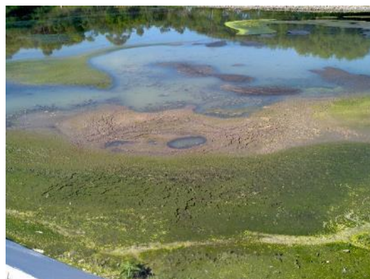
Figura 79 – Excesso de lodo na lagoa de Polimento da ETE Civit II.
