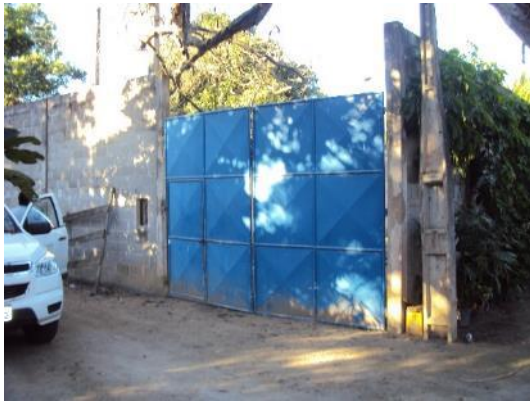
Figura 63 - Entrada da EEEB Fazendinha sem identificação.
