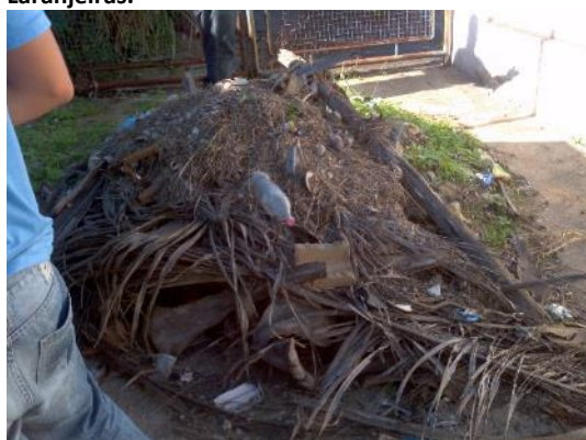
Figura 41 - Entulho na área interna da EEBB Aldeia de Laranjeiras
