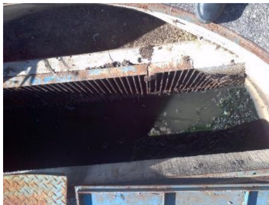
Figura 48 - Gradeamento da EEB Portal de Manguinhos V.
