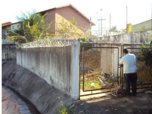
Figura 37 – Entrada da EEBB Aldeia de Laranjeiras sem identificação.
