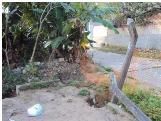
Figura 93 - Entorno da EEB Mar Azul sem isolamento adequado.
