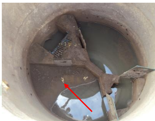
Figura 6 - Mecanismo de remoção de sólidos grosseiros da EEEB Boulevard Lagoa I.
