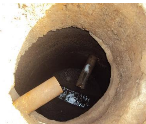
Figura 88 - Poço de Visita da rua dos Eucaliptos do Sistema Feu Rosa.
