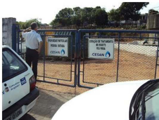
Figura 96 - Entrada da ETE Feu Rosa identificada.
