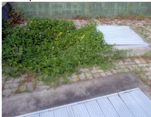
Figura 12 - Biofiltro da EEEB Boulevard Lagoa II.
