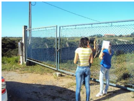
Figura 47 - Entrada da EEB Portal de Manguinhos V sem identificação.
