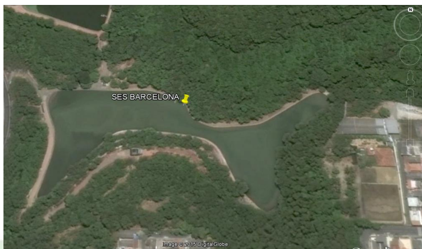
Figura 35 - Vista aérea da ETE Barcelona.
