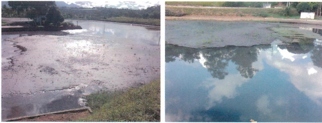
Figura 33 - ETE André Carloni antes da retirada do lodo. Fonte: Ofício nº D-MA 009/003/2015.
