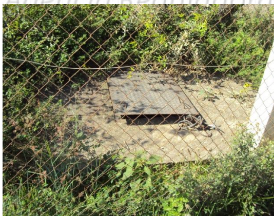
Figura 10 - Tampa do poço de sucção da EEEB 3 e demanda de limpeza da área.
