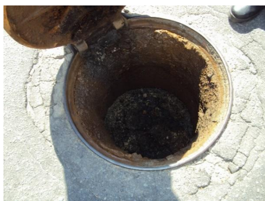
Figura 4 - Poço de Visita – Rua Santa Terezinha.
