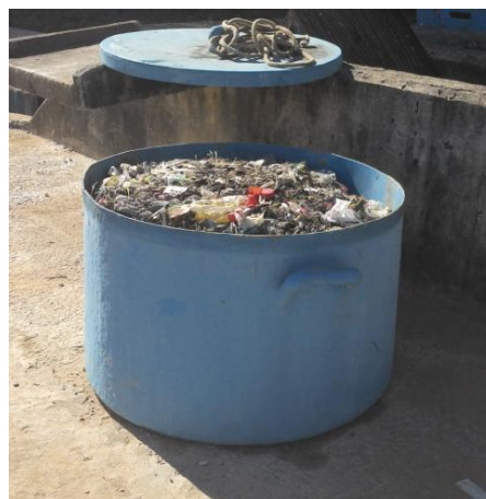
Figura 25 - Caixa de armazenamento de resíduos do gradeamento.
