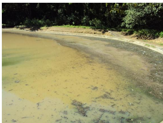
Figura 59 - Excesso de sobrenadante na lagoa facultativa da ETE Barcelona.
