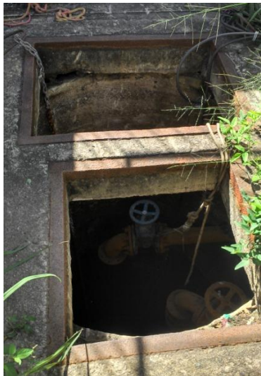
Figura 6 - Ausência de tampa no poço de sucção da EEEB 1 do SES André Carloni.
