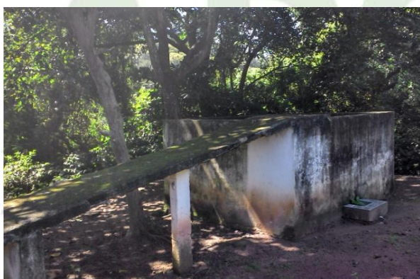
Figura 61 - Caixa de resíduos da lagoa facultativa da ETE Barcelona.
