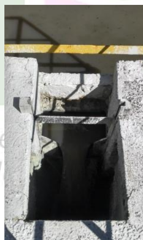
Figura 62 - Vertedouro da saída de efluente da lagoa facultativa da ETE Barcelona.
