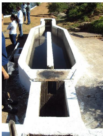
Figura 24 – Gradeamento e caixa de areia com vertedor triangular.
