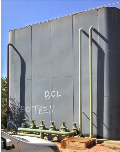
Figura 54 - Reator UASB da ETE Barcelona.
