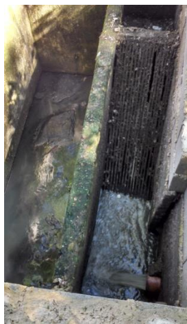
Figura 43 - Gradeamento da EEB Delegacia.
