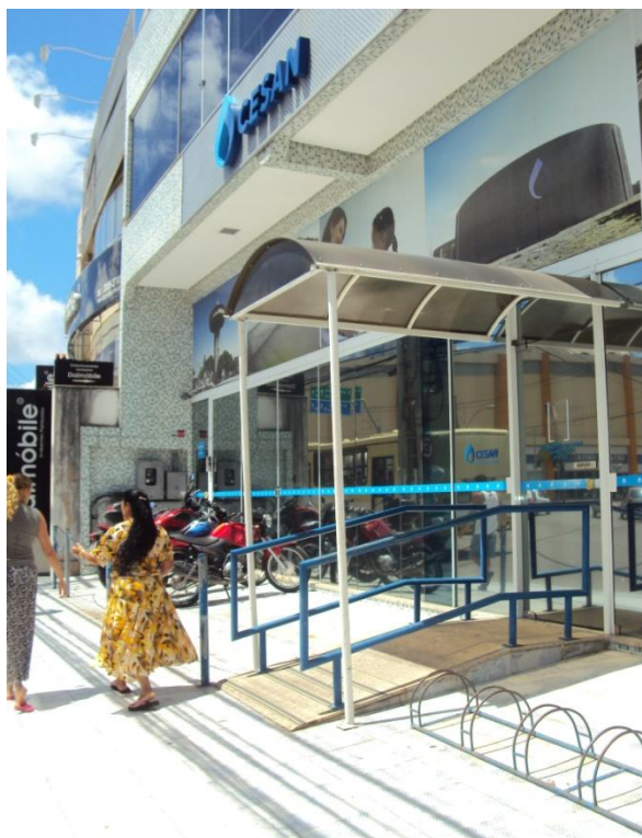
Figura 1 - Fachada do Escritório de Atendimento da Serra.
