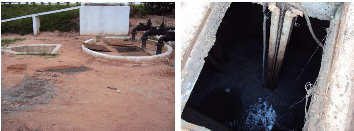
Figura 10: Estação Elevatória de Esgoto Bruto.
