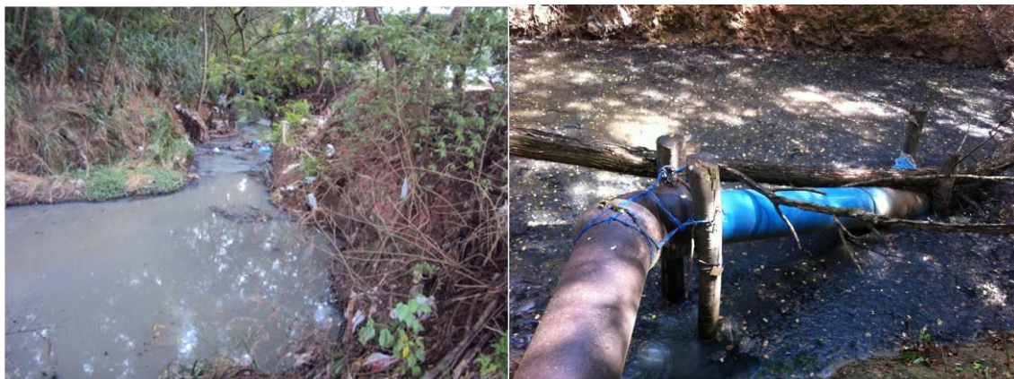
Figura 20: Córrego Irema, antes do lançamento (esquerda), e tubulação de afogada para despejo do efluente (direita).
