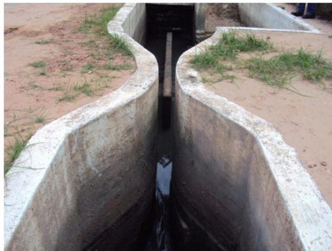
Figura 8: Calha Parshall.
