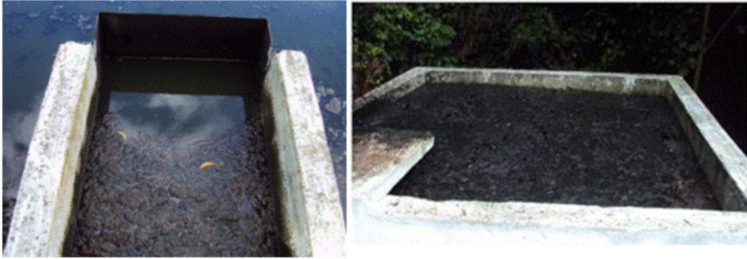
Figura 18: Caixa de saída do efluente da lagoa 02 e caixa de armazenamento de resíduos das lagoas.
