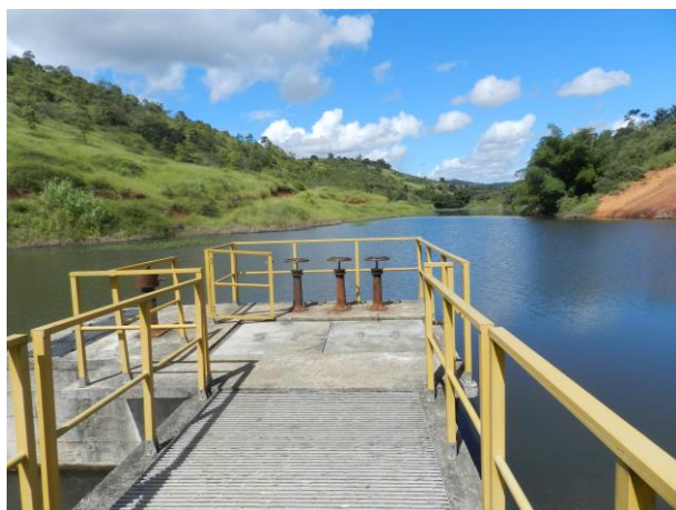
Figura 1 – Captação Barragem do Córrego Seco.
