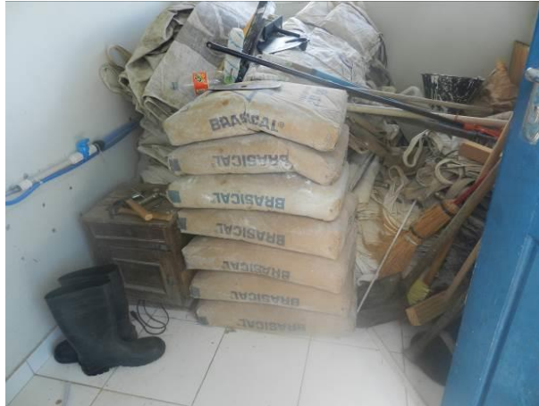
Figura 13 - Depósito da ETE São Gabriel da Palha.
