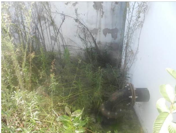
Figura 16 – EEAT Morar Bem.
