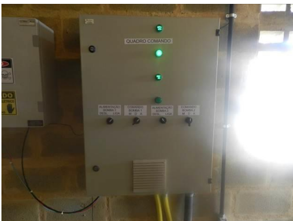
Figura 7 - EEAT Morar Bem.
