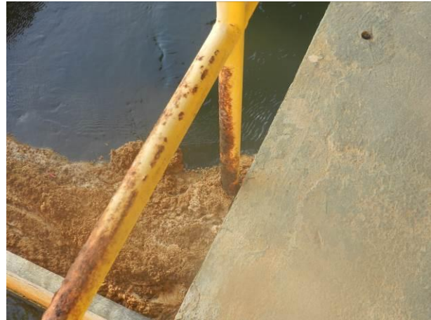
Figura 12 – ETA São Gabriel da Palha.
