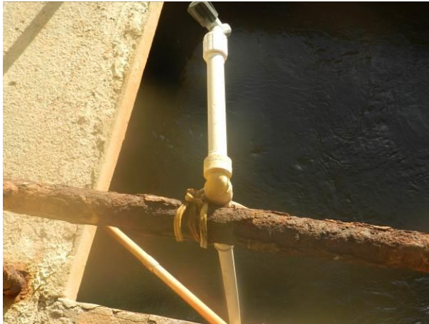
Figura 12 – ETA São Gabriel da Palha.
