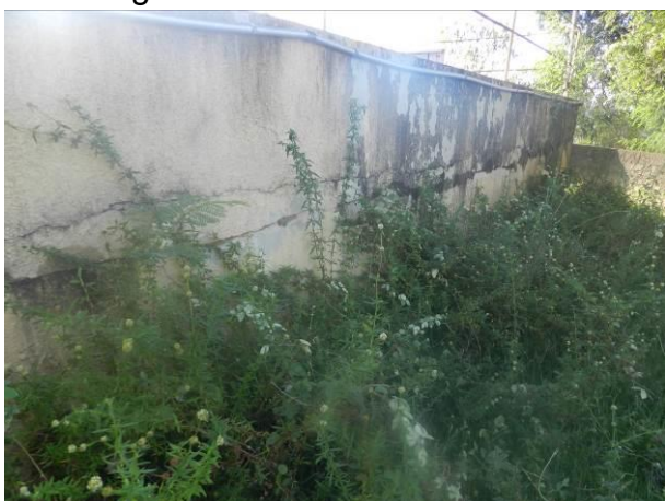
Figura 18 – ETA São Gabriel da Palha
