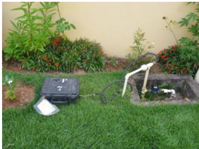
Figura 2 - Equipamento de medição instalado no Ponto 02 - Município de Santa Teresa, ES
