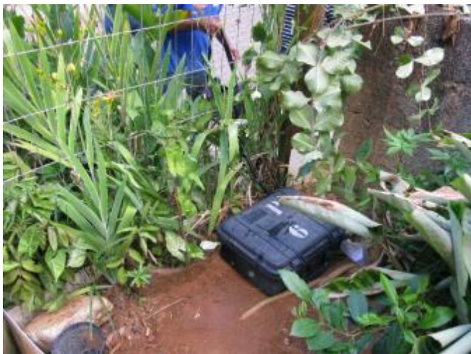
Figura 1 - Equipamento de medição instalado no Ponto 01 - Município de Santa Teresa, ES
