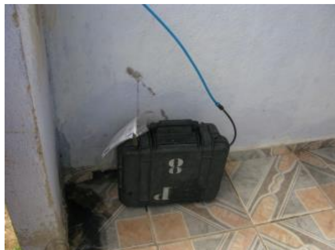
Figura 4 - Equipamento de medição instalado no Ponto 03 - Município de Santa Teresa, ES
