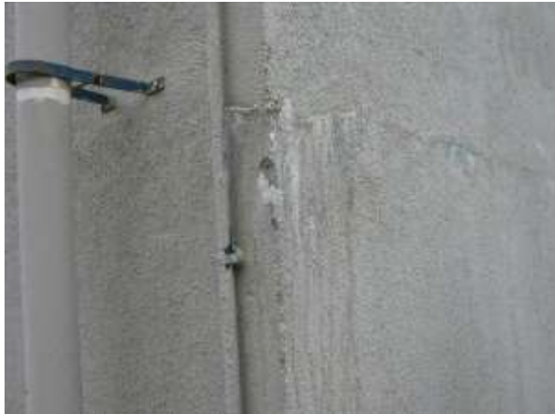
Figura 3 - Parede externa do reservatório de 200m 3 .
