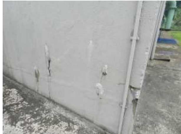
Figura 4 - Parede externa do reservatório de 200m 3 .
