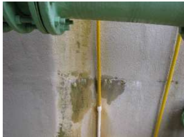
Figura 2 - Paredes externas do filtro.
