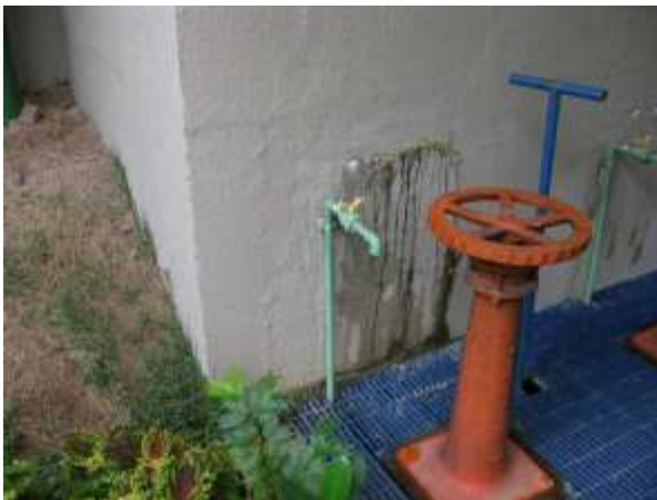
Figura 1 - Paredes externas do filtro.
