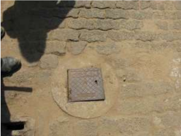
Figura 9 - Descarga na Rua José Machado Alvarenga.
