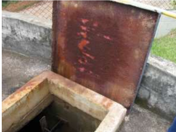
Figura 8 - Tampa do reservatório de formato cilíndrico.
