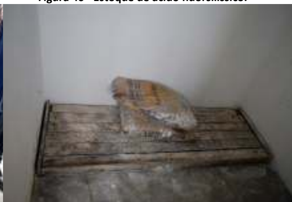
Figura 48 - Área destinada ao estoque de cal.
