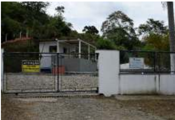
Figura 19 - ETA Rio Novo do Sul com identificação.
