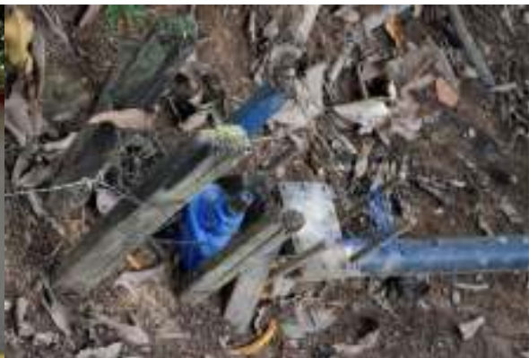
Figura 16 - Registro da EEAB exposto nas proximidades.
