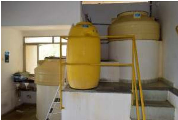
Figura 31 - Acondicionamento dos agentes químicos do tratamento (Ácido fluorsilícico e Sulfato de Alumínio).
