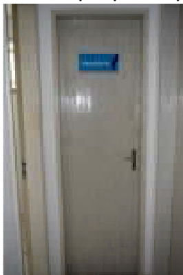
Figura 39 - Vestiário da ETA Rio Novo do Sul.
