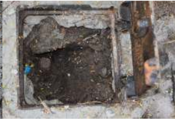
Figura 70 - Descarga 4 com excesso de areia.
