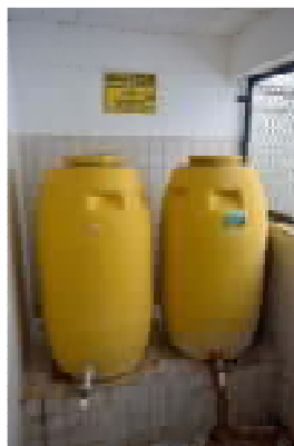
Figura 46 - Estoque de ácido fluossilícico.
