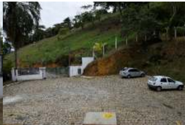
Figura 20 - Pátio da ETA Rio Novo do Sul.
