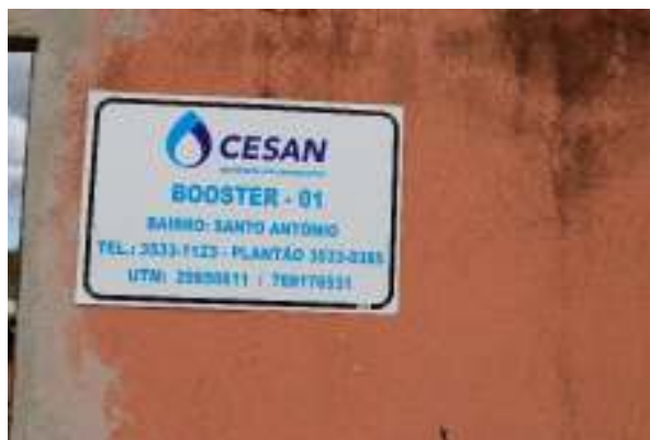
Figura 73 – Booster Santo Antônio com identificação.
