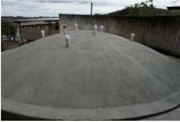
Figura 60 - Reservatório apoiado semienterrado.
