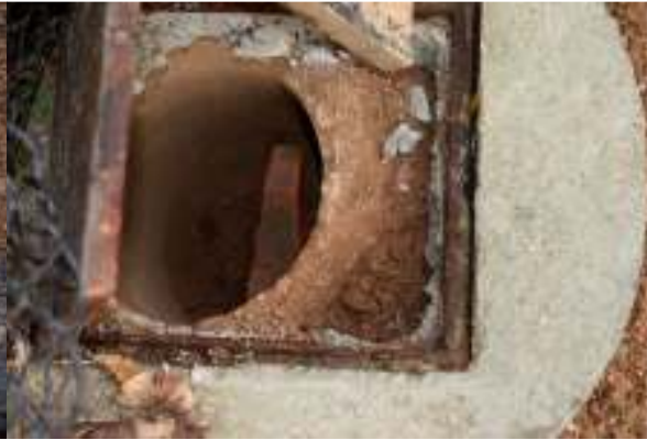
Figura 65 - Descarga 2 com condições de conservação e operação satisfatórias.
