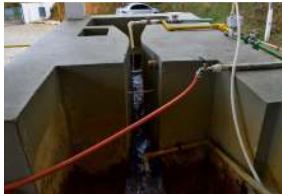
Figura 22 - Unidade de mistura rápida.
