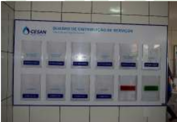
Figura 83 - Quadro de distribuição de serviços.
