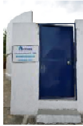
Figura 61 - Reservatório apoiado semienterrado identificado.
