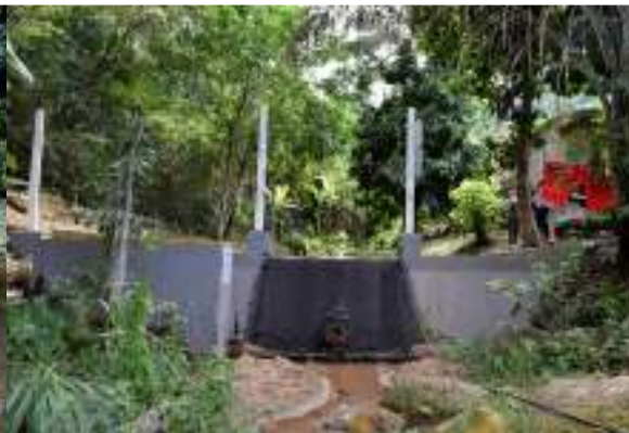
Figura 6 - Barramento instalado no Córrego São Vicente.
